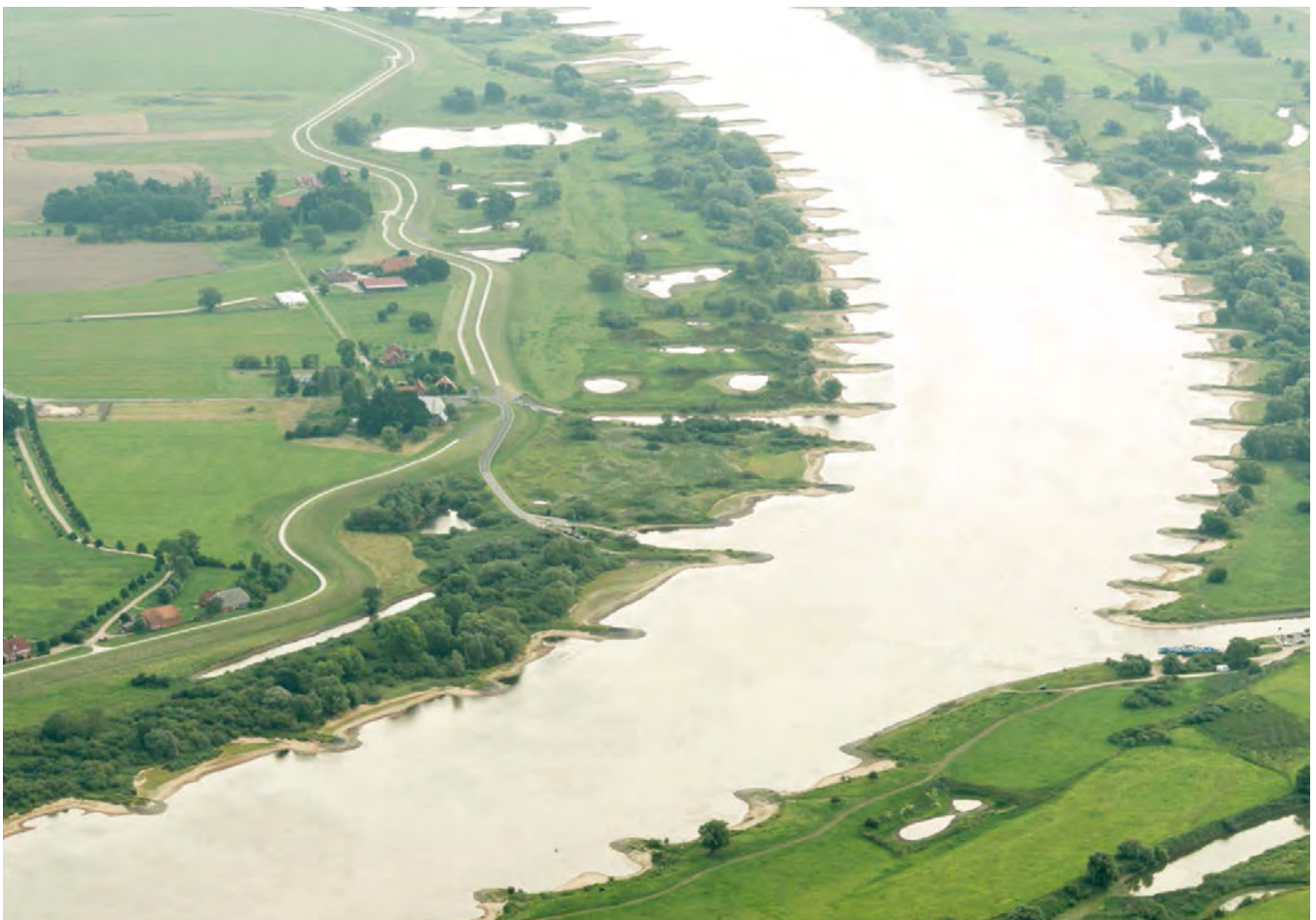
Abbildung 17: Unregelmäßiger Deichverlauf infolge von ehemaligen Deichbrüchen und Bebauung bei Neu Bleckede
