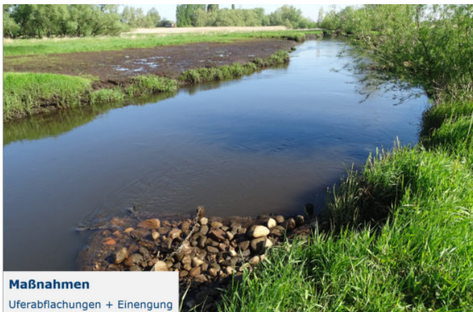
Abb. 32: Uferabflachung und Querschnittseinengung (Foto: UNB Landkreis Harburg)
