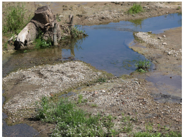
Abb. 6: Wurzelstubben und Feinkiesdepots strukturieren die neue Gewässersohle und beschleunigen die eigendynamische Gewässerentwicklung. (Foto: Bernd Schackers)
