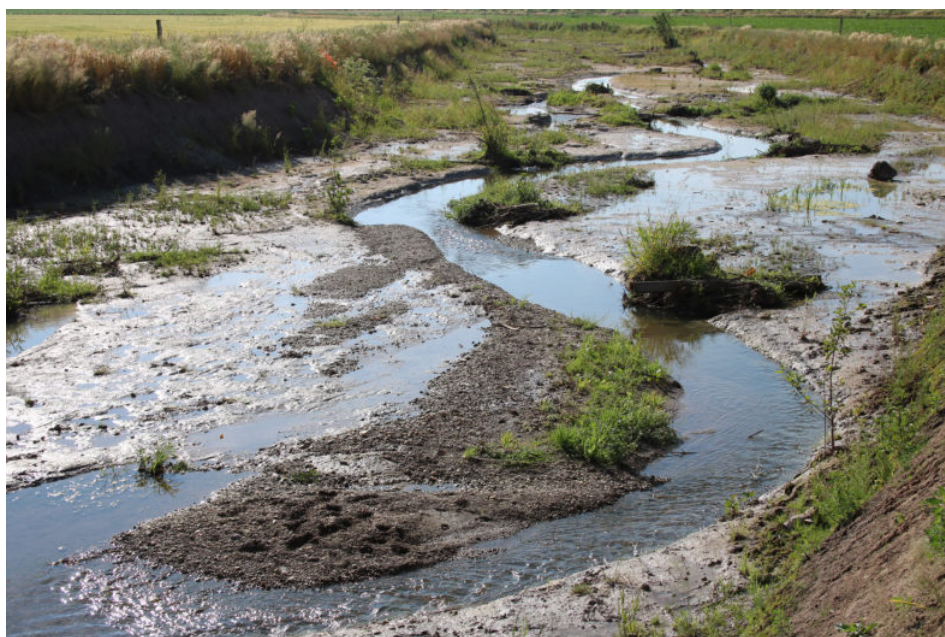
Abb. 2: Die Profilgeometrie wurde so gewählt, dass die Eder bereits bei doppeltem Mittelwasserabfluss über die Ufer tritt und die Sohle der Sekundäraue weiter strukturiert. So bildeten sich bereits nach dem ersten kleinen Hochwasserereignis Rinnen und Mulden aus, die sich zu temporären Kleingewässern entwickelt haben. Auf dem Bild sind auch unterschiedliche Strömungsmuster zu erkennen. (Foto: Bernd Schackers)
