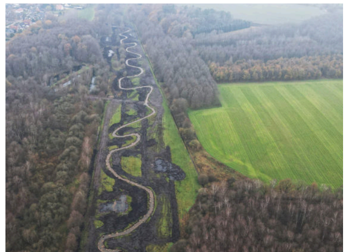
Abb. 23: Esteverlauf nach der Maßnahme (Foto: UNB Landkreis Harburg)
