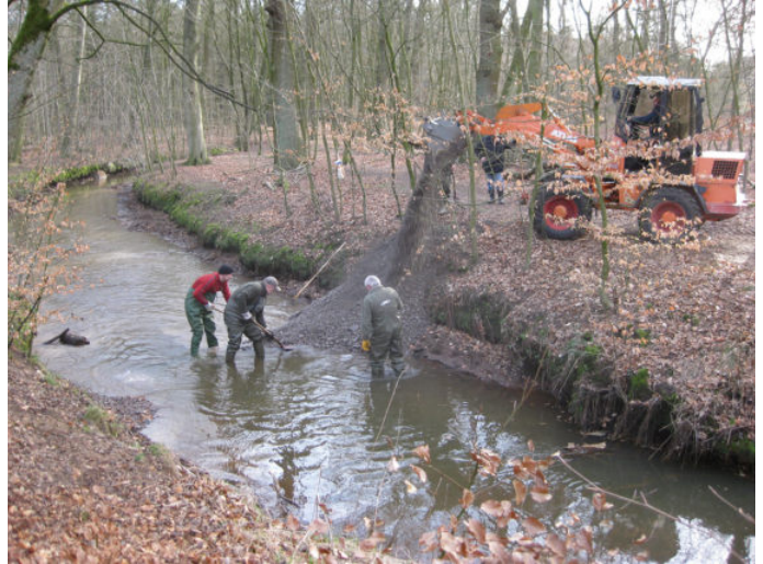
Abb. 2: Kieseinbau in der Welse (Foto: Jens Salva)
