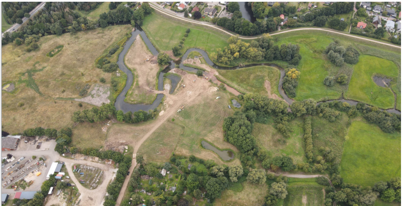
Abb. 29: Planungsgebiet (Südteil) nach der Maßnahme (Foto: UNB Landkreis Harburg)
