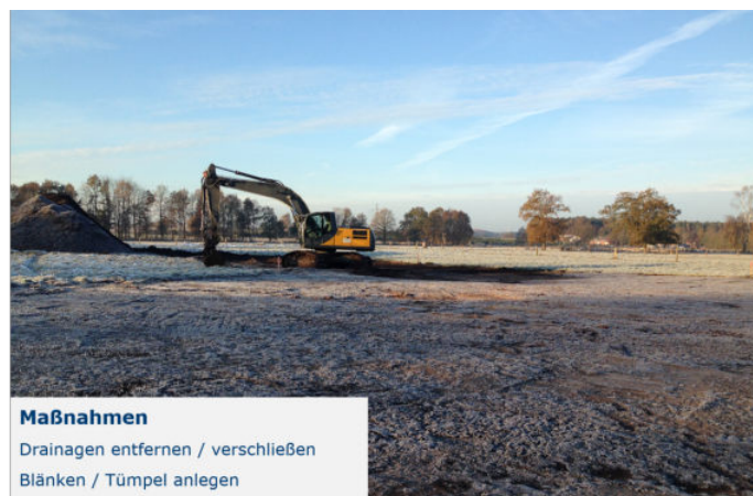
Abb. 10: Drainagen entfernen (Foto: UNB Landkreis Harburg)
