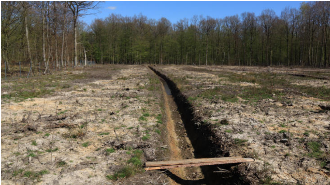
Abb. 5-9: Großer Kahlschlag mit Standortveränderung durch Entwässerungsgräben und Verteilung des Aushubs; EU-Vogelschutzgebiet Schaumburger Wald (2020)
