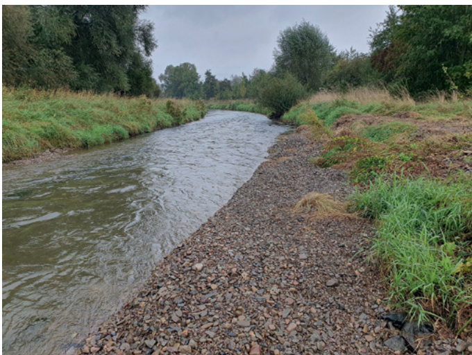
Abb. 4: Anlage von Kiesdepots im Rahmen eines Geschiebemanagements und Öffentlichkeitsarbeit des Leineverbandes nach der Umsetzung von Maßnahmen (Fotos: F. Prosch)
