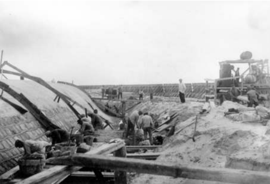
Abb. 4: Herstellung des S-Profiles (1926 bis 1928)
