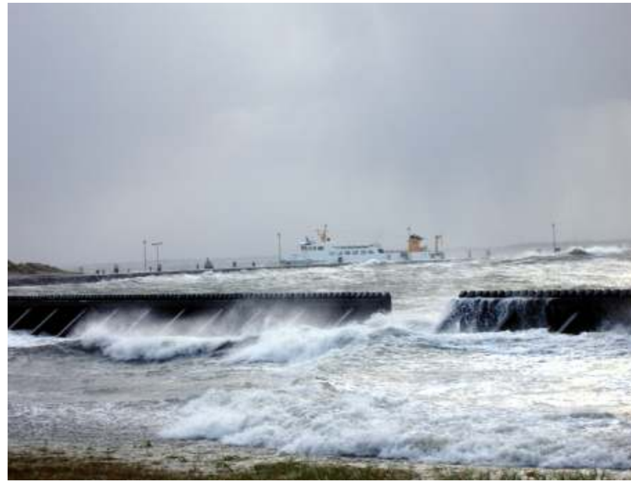
Abb. 2: Pfahlschutzwand bei der Sturmflut vom 9. November 2007
