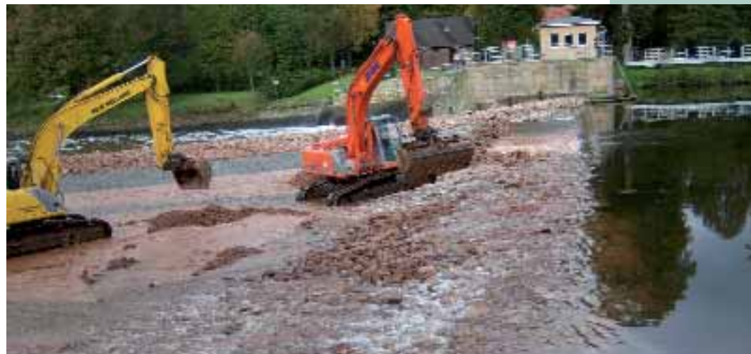
Bauarbeiten am Wehr.
