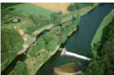
Luftaufnahme altes Wehr.
