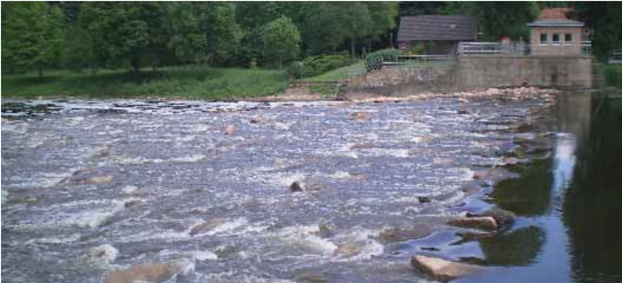
Raue Rampe nach der Fertigstellung.
