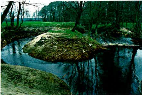
Foto 34: Absturz mit Umlauf
