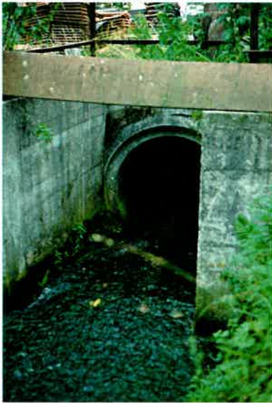
Foto 45: Verrohrung ohne Sediment
