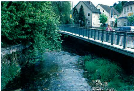
Ftp 147: kein Randstreifen; Nutzung Straße (rechts)
