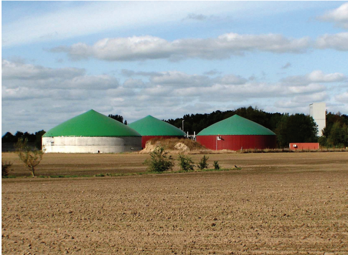
Bild 15: Biogasanlage im Landkreis Gifhorn
