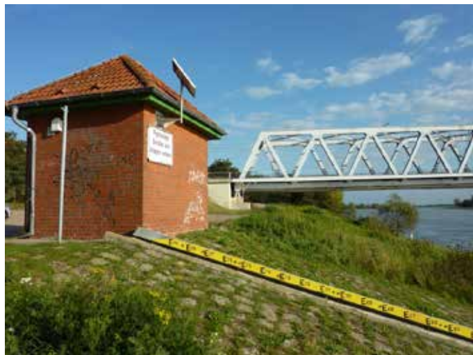
Abbildung 16: Pegel Wittenberge, September 2011 ** nach Kappung des Elbescheitels durch Deichbrüche und Flutung der Havelniederung
