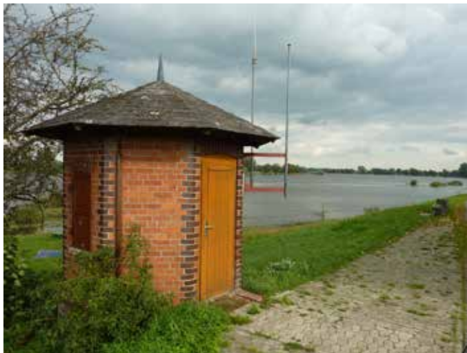
Abbildung 20: Pegel Damnatz bei Hochwasser, Oktober 2010
