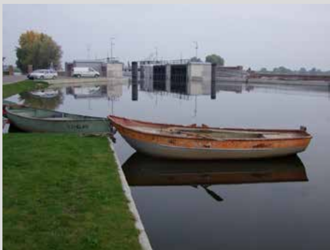
Abbildung 21: Pegel Hitzacker am Sielbauwerk, 2010
