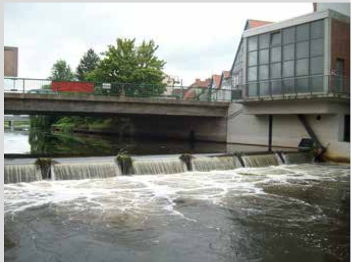
Abbildung 25: Pegel an der Jeetzel am Wehr Lüchow (OW) Abflussmessstelle an der Brücke unterhalb der Wehranlage Lüchow
