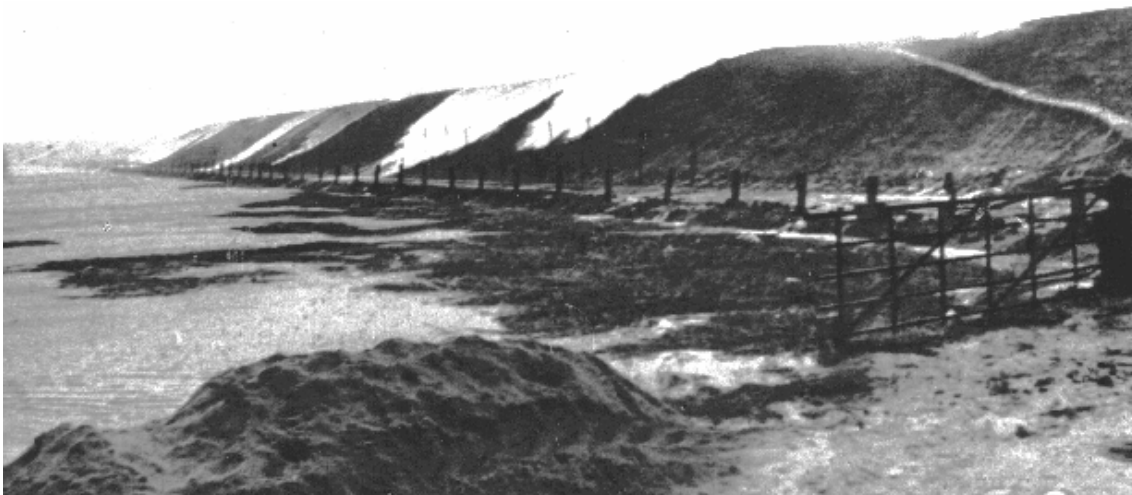
Abb. 3.5: Wellenüberlauf an einem Seedeich (Foto: H.-J. Gärtner, Heide)
