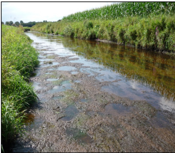
Abb. 14: Niedrigwasserstand im ausgebauten Unterlauf der Haaren vor Bloher Landstrasse. Das breite und vollständig geräumte U-Profil führt zu niedrigen Wasserständen, rascher Temperaturerhöhung im Sommer bei Tage mit Folge geringer Sauerstoffsättigung.
