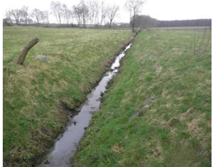
Abb. 9: Werpelohrer Grenzgraben (Ems), Trapezprofil mit degenerierten Uferstrukturen an einem ausgebauten Tieflandbach
