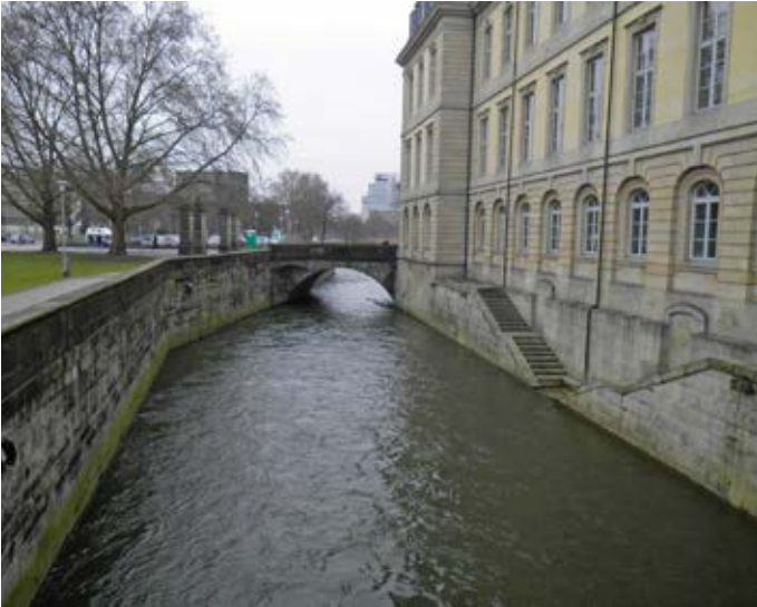
Abb. 12: Leine (Weser), städtischer Bereich in Hannover mit Ufermauern
