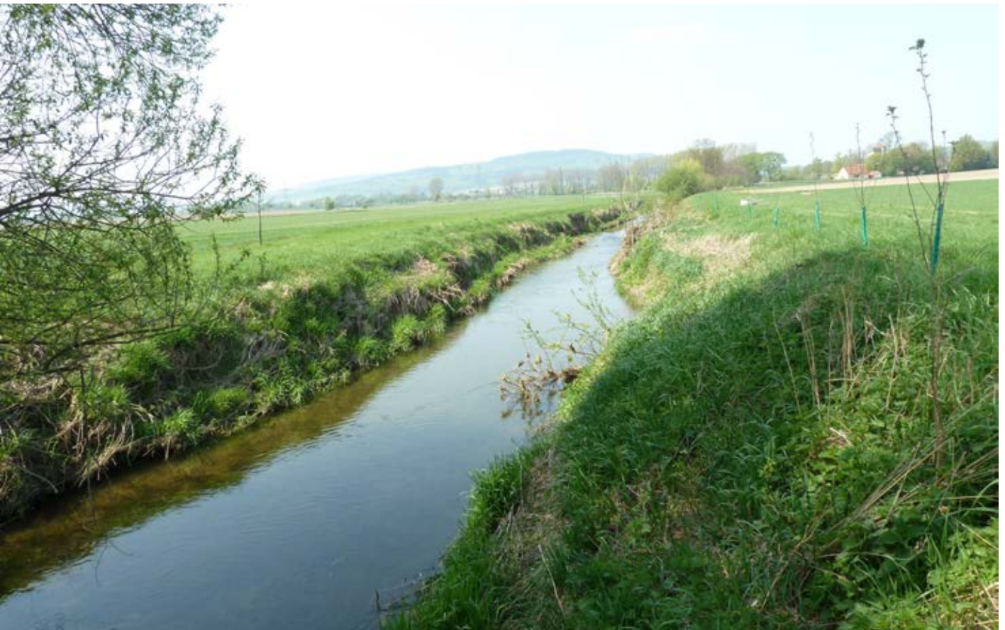
Abb. 23: Verfallendes Regelprofil und beginnende Laufentwicklung der begradigten Saale (Weser) nach reduzierter Ufersicherung
