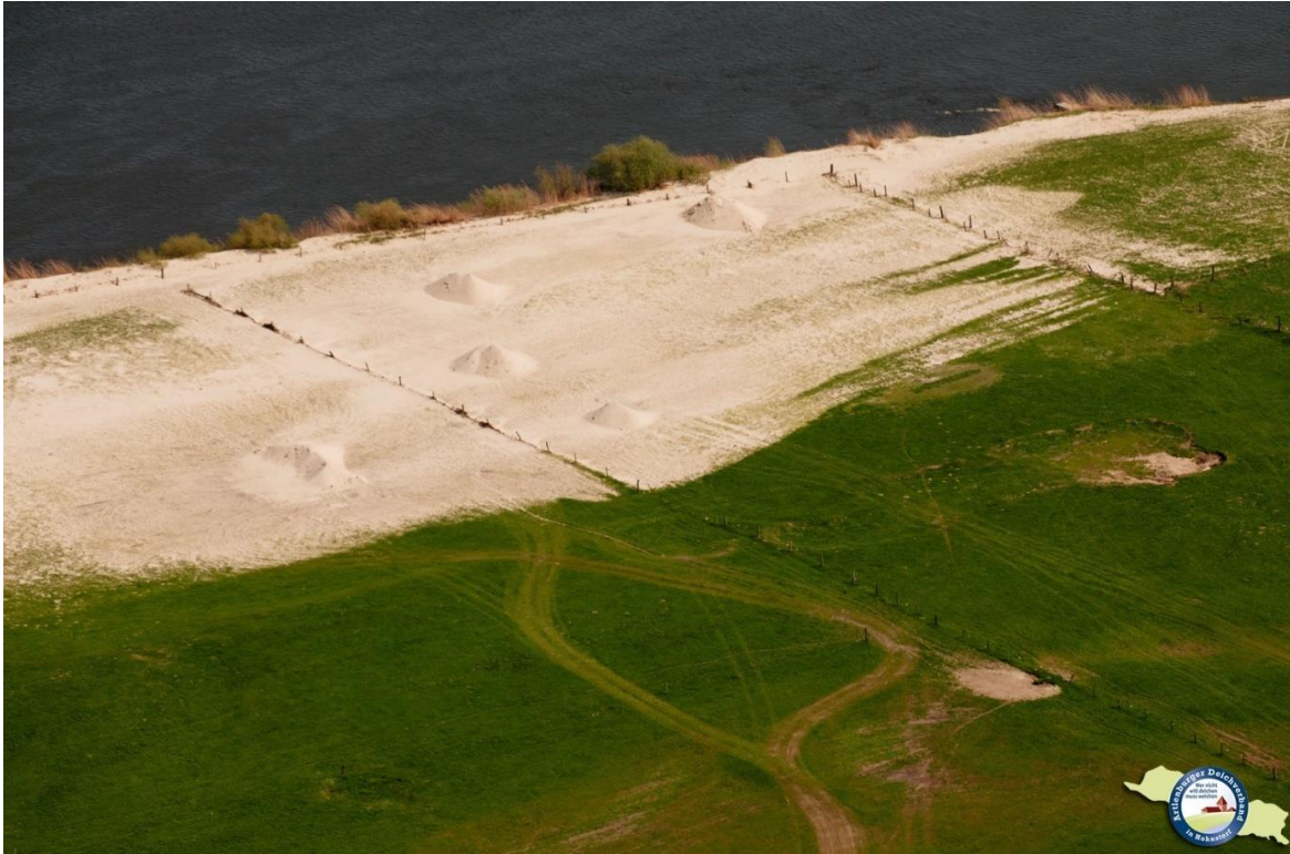
Foto 3.5 Sedimentausttrag aus der Elbe beim Hochwasser im Januar 2011 zwischen Geesthacht und Artlenburg (Quelle: Artlenburger Deichverband)
