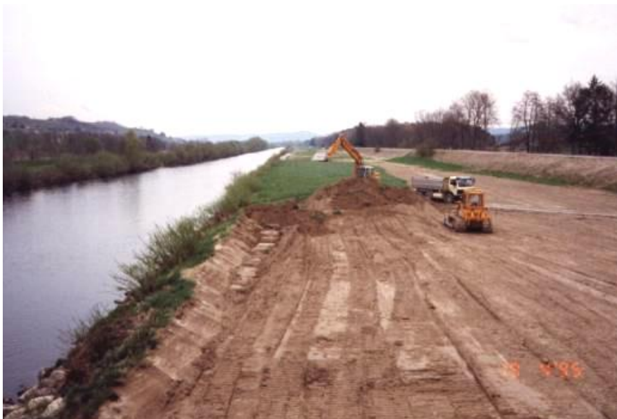
Foto 3.4 Entfernung der Sedimentablagerungen von den Vorländern der Thur (Quelle: Göldi)
