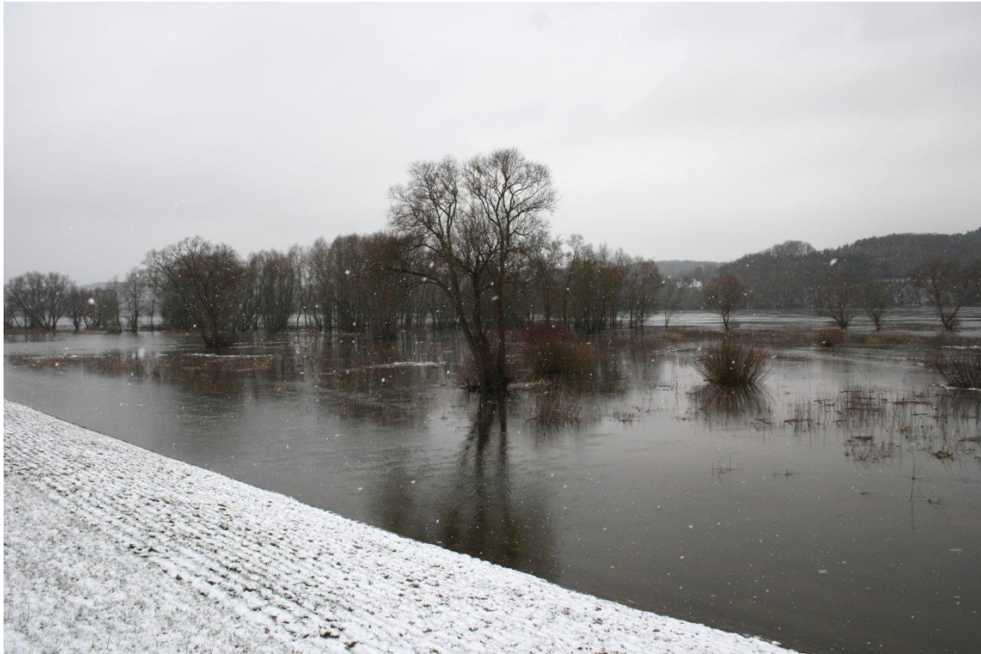
Abb. A.101 Bewuchs aus Sträuchern, Hart- und Weichholz bei Privelak, ca. Elbe-km 529, rechtes Ufer (Blick stromauf)
