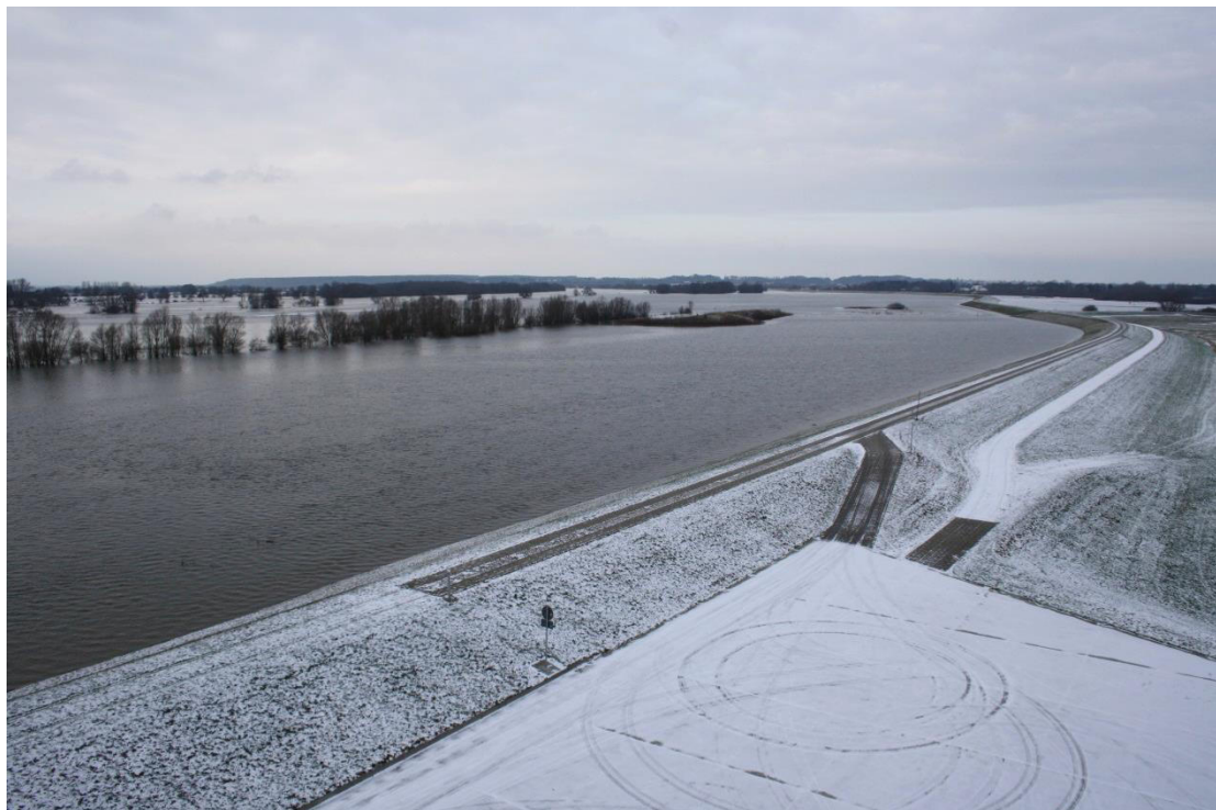
Abb. A.104 Bewuchs im rechten Vorland an der Landesgrenze zwischen Niedersachsen und Mecklenburg-Vorpommern bei Elbe-km 554,5, rechtes Ufer (Blick stromab)
