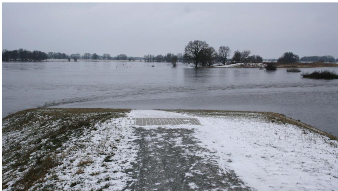
Abb. A.96 Elbe-km 477 rechts, Einströmung durch Schlitz 1 der Deichrückverlegung Lenzen am 18. Januar 2013 bei einem Abfluss am Pegel Wittenberge von ca. 1590 \text{ m}^3/\text{s} ( < \text{MHQ} ), Blick stromab
