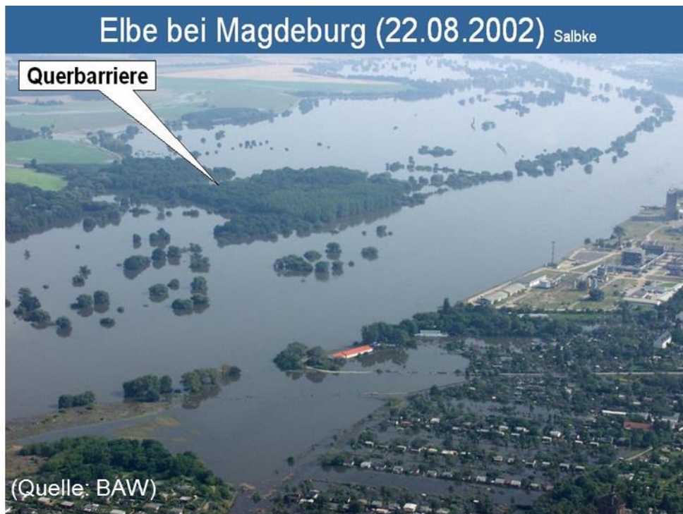
Foto 3.11 Querbarriere auf dem Elbe-Vorland bei Magdeburg im Jahr 2002 (Quelle: Bundesanstalt für Wasserbau)
