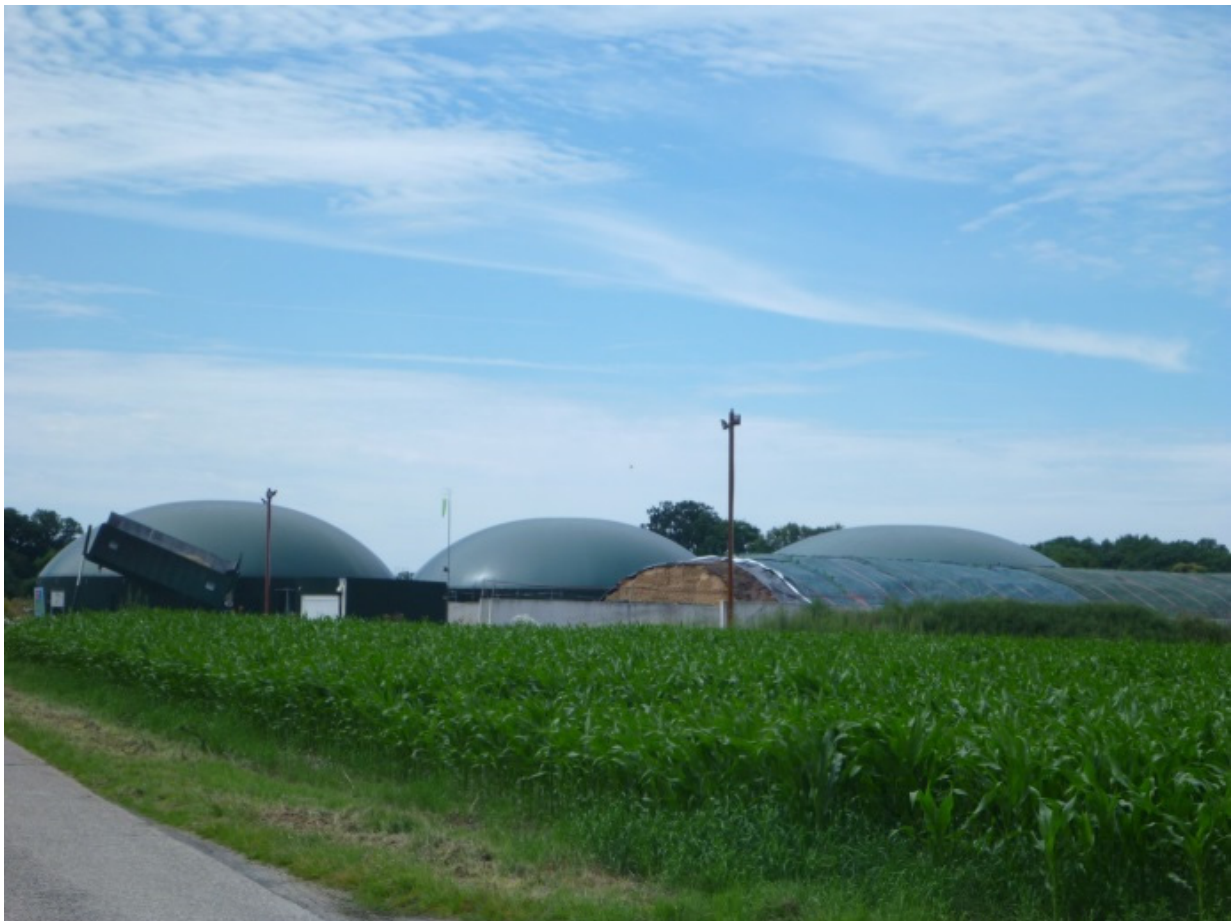
Abb. 25: Biogasanlage im Einzugsgebiet Ems-Nordradde.
