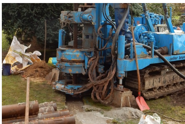
Abb. 38: Bohrung einer Grundwassermessstelle.
