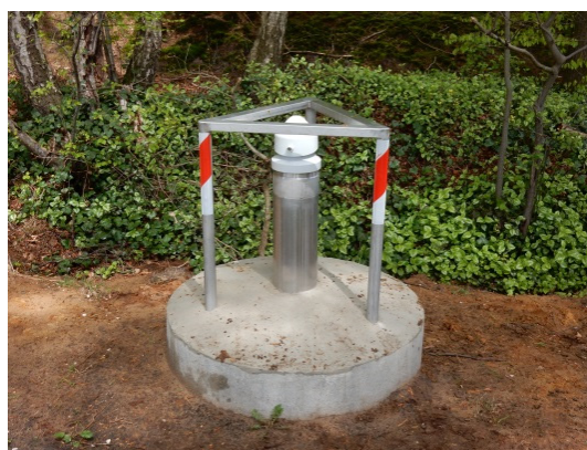
Abb. 39: Fertiggestellte Messstelle mit Sicherheitsdreieck.
