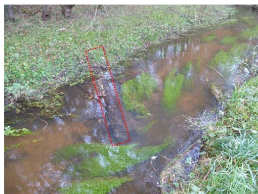
Abb. 5.10.4–5.10.8: Ausgangszustand sowie Einbauten inklinanter Tothholzstämme (Lage rot punktiert), z. T. m. Kiesanschüttung (Fotos: P. Suhrhoff, 07.2016 (Ausgangszustand) bzw. 11.2017)
