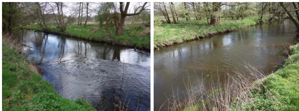
Abb. 5.10.17 und 5.10.18: Leicht inklinant eingebaute Lenkbuhnen aus Kies in der Seeve (Fotos: P. Suhrhoff, 04.2016)
