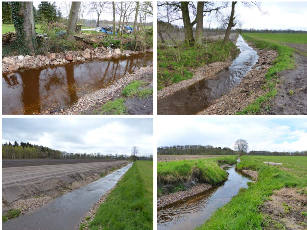
Abb. 5.2.16–5.2.19: Beispiele für ungünstige Kieseinbauten, vgl. Abb. 5.2.1 (Fotos: S. Nickel, 2016)
