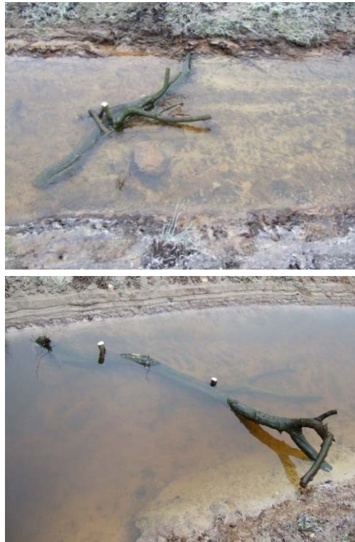
Abb. 5.3.4–5.3.6: Fixierung kleinerer Totholzstrukturen in einem Bach (Neubauabschnitt) über Holzheringe; direkt nach Einbau (Fotos: P.Suhrhoff, 2007).
