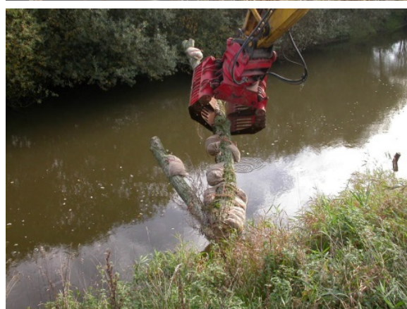
Abb. 5.3.1–5.3.3: Einbau von Pappelstämmen mit Beschwerung über Kiessäcke (Fotos: V. Knuth, 2006).
