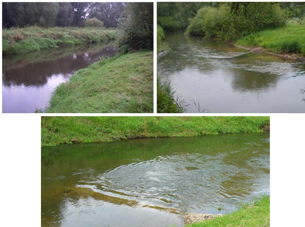
Abb. 5.10.14–5.10.16: Vorzustand und Wirkung zweier Einbauten inklinanter Steinbuhnen in die Oker bei Hillerse (Fotos: R. Moews, 2015)
