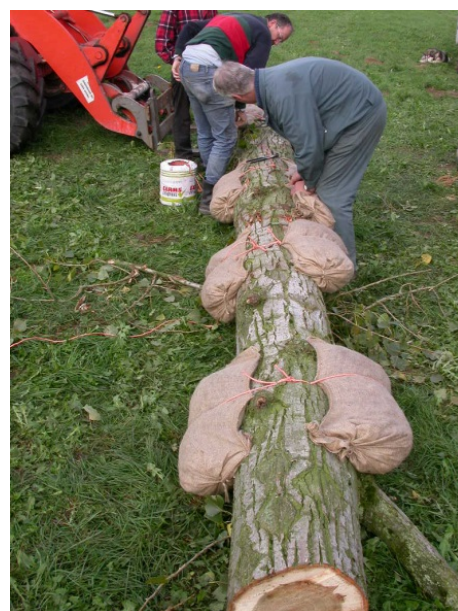
Abb. 5.3.1–5.3.3: Einbau von Pappelstämmen mit Beschwerung über Kiessäcke (Fotos: V. Knuth, 2006).
