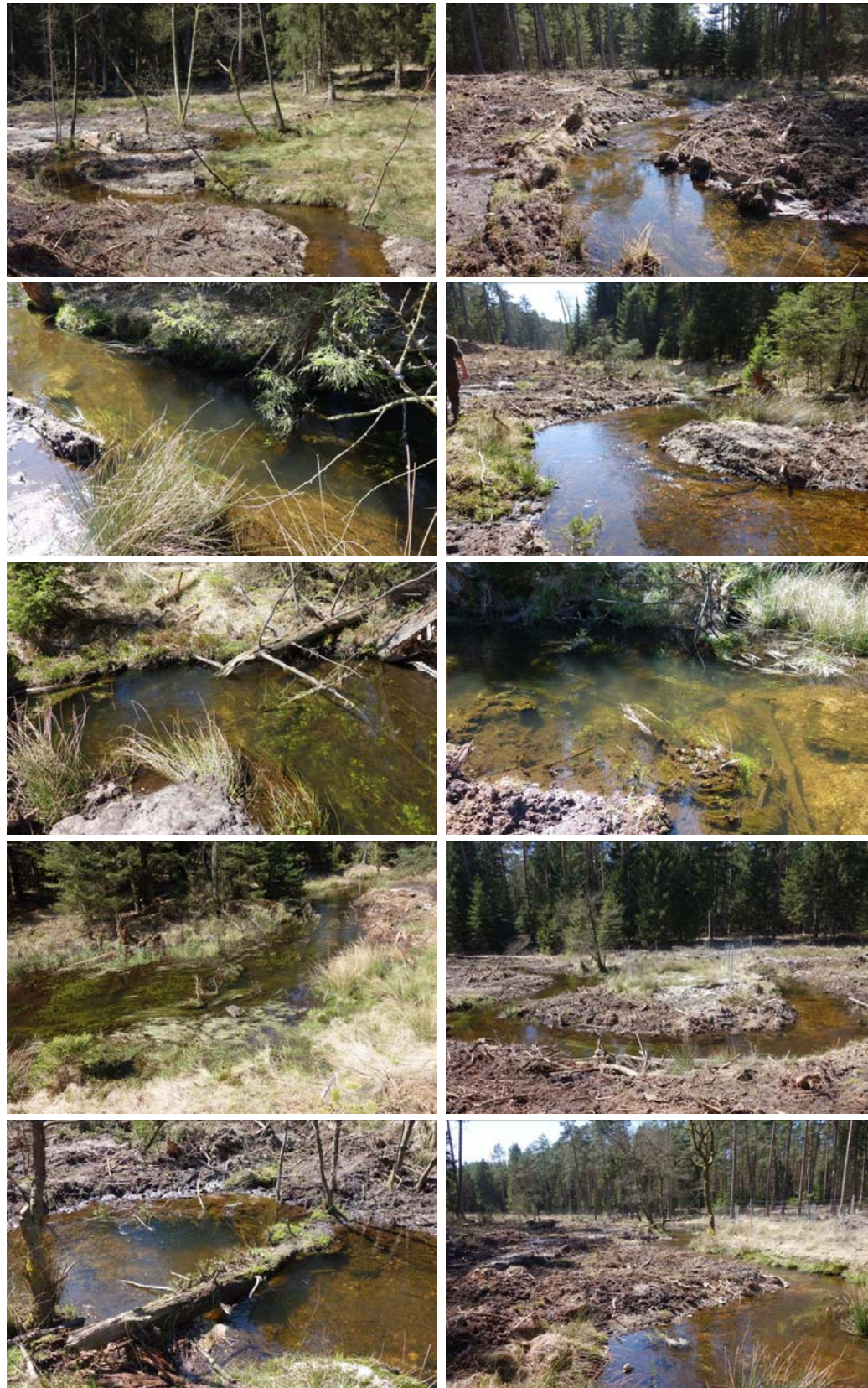
Abb. 5.2.6–5.2.15: Renaturierung eines ehemals stark lateral überdimensionierten Lutter-Abschnittes durch Kieseinbau, kurz nach Abschluss der Baumaßnahmen (Fotos: P. Suhrhoff, 2016)
