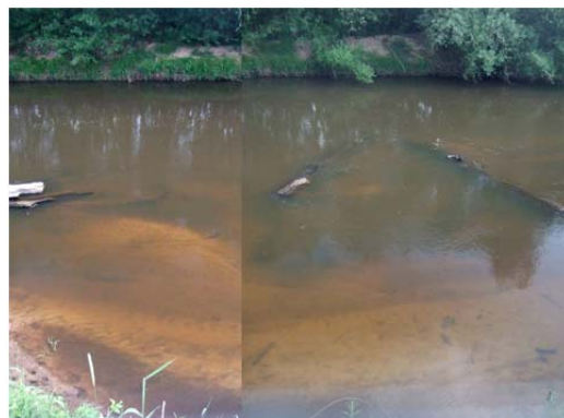
Abb. 5.3.11 Gleiches Einbaubeispiel, Äste im Vordergrund ± übersandet (Foto: P. Suhrhoff, 2009)
