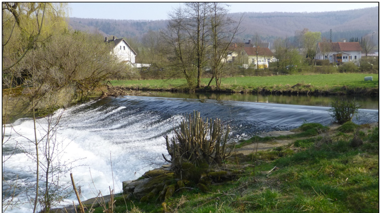
Abb. 5: Querbauwerk 456-S01 in Bad Pyrmont, Streichwehr Dringenauer Mühle. Links befindet sich die Wasserkraftanlage (nicht im Bild).
