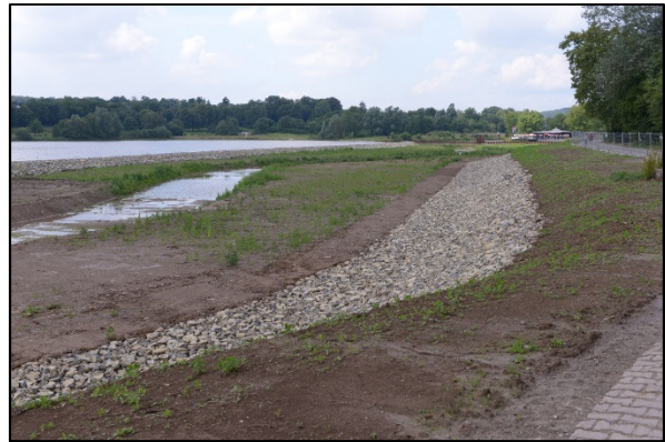
Abb. 1: Vorprofilierter Umflut zwischen Schiedersee (links) und Emmer-Radweg (rechts), Aufnahme 2014.
