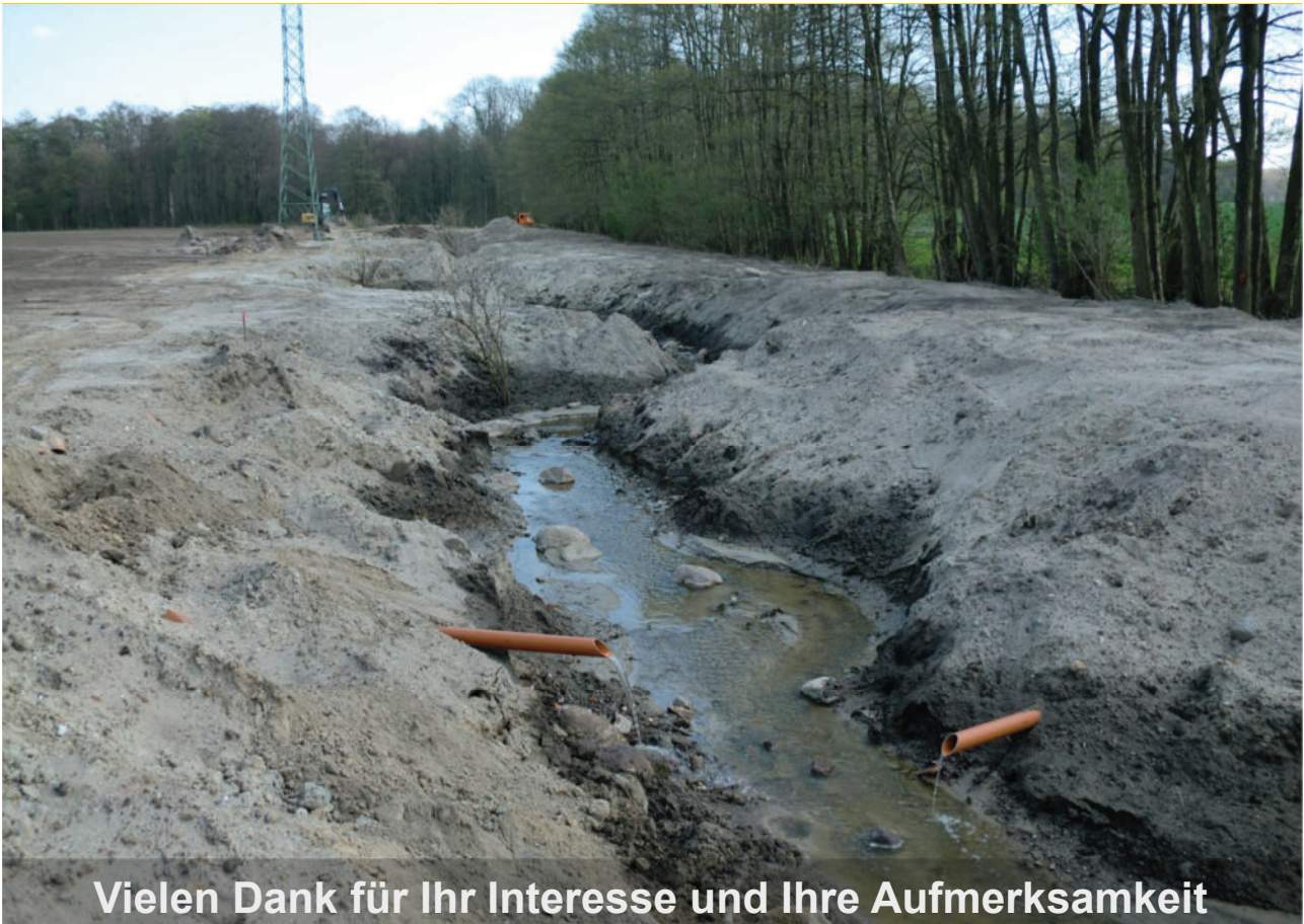
Renaturierung Haubach (Mecklenburg-Vorpommern); einmündende Dränsammler während der Bauphase
