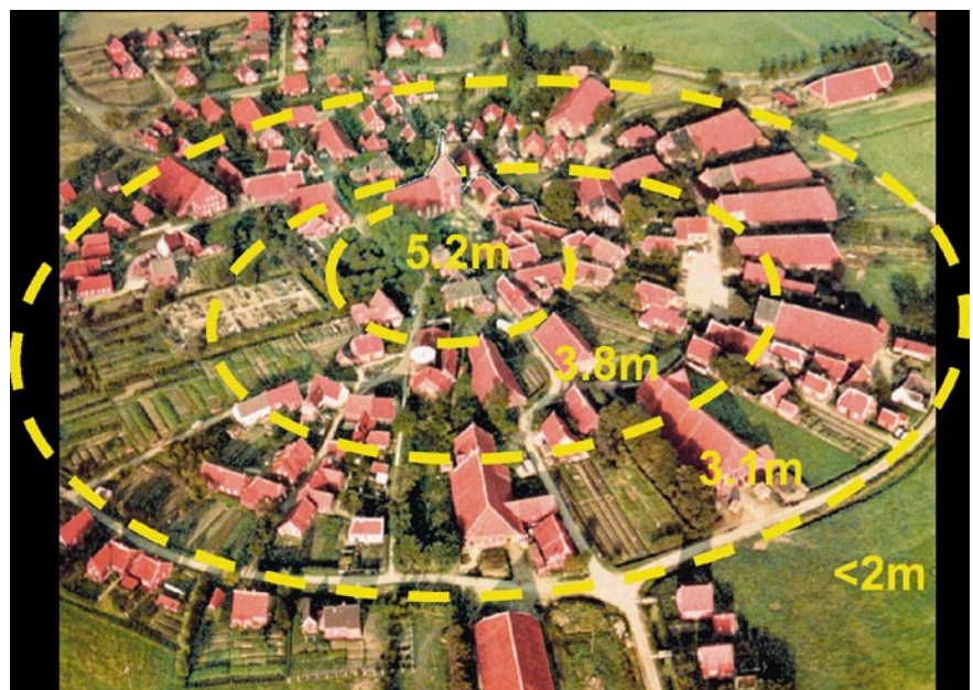
Bild 2: Warft Rysum: Eine Anpassung würde einen kompletten Abriss und anschließende Neuerrichtung der Bauwerke und Infrastruktur nach Erhöhung der Warft bedeuten
