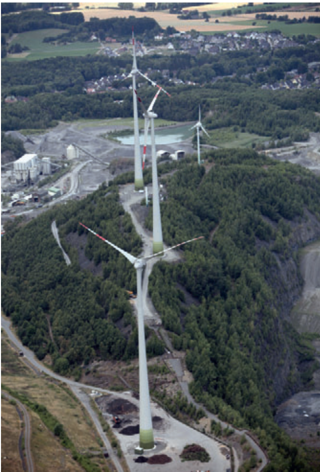
Abb. 2: Repowering der Windkraftanlagen auf dem Piesberg in Osnabrück (Foto: Gert Westdörp)
