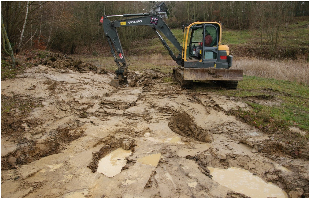
Foto 22: Abschieben des Oberbodens zur Neuanlage von Gelbbauchunkengewässern am Hang (2018)
