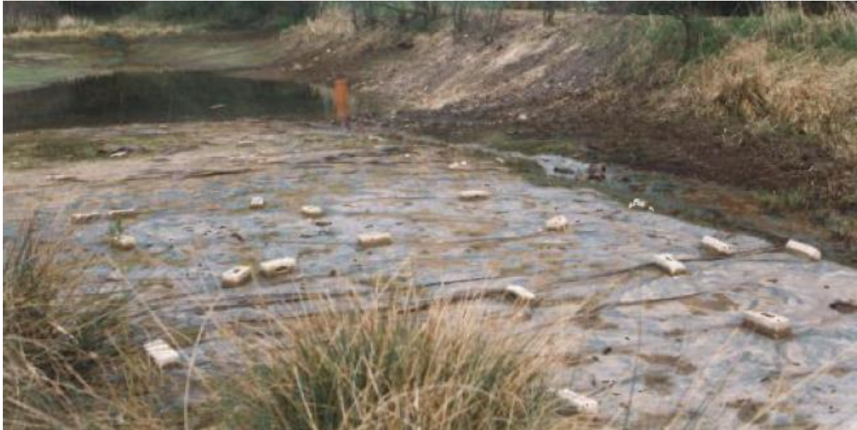
Abbildung 8: Gewässer 370-04 (Südost- Bereich): Gewässerausbau mit Sohlsicherung durch Folie und Steine sowie Grundablass
