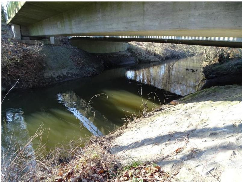
Abbildung 13: Unter der Brücke der Bundesstraße 188 beim Ersepark sind sowohl das Ufer als auch die Bermen sehr steil und damit nur bedingt für den Fischotter durchgängig (03.03.2022, NEUMANN)
