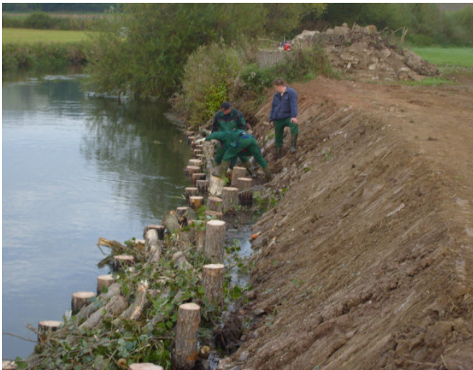
Abb. 27: Punktuelle Sicherung des Böschungsfußes im Pralluferbereich (Foto: Leineverband)
