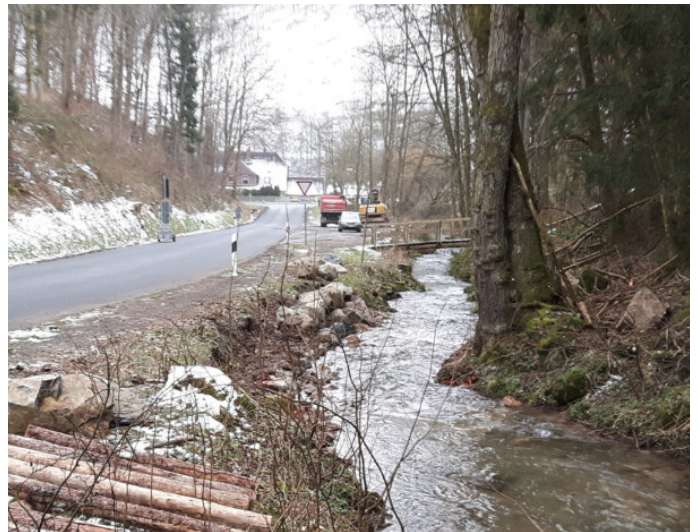
Abb. 26: Lokale Ufersicherungsarbeiten im Bereich einer Kreisstraße (Foto: Jochen Lampert)
