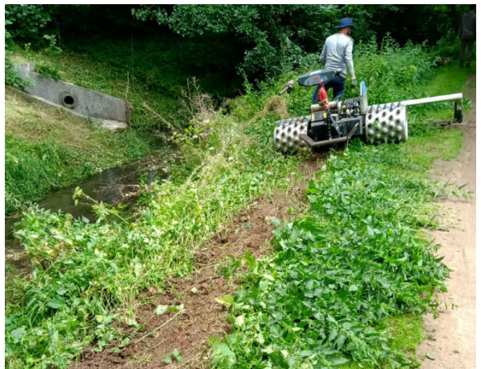
Abb. 28: Mäharbeiten auf dem Randstreifen mit handgeführten Mähgeräten (Foto: Leineverband)
