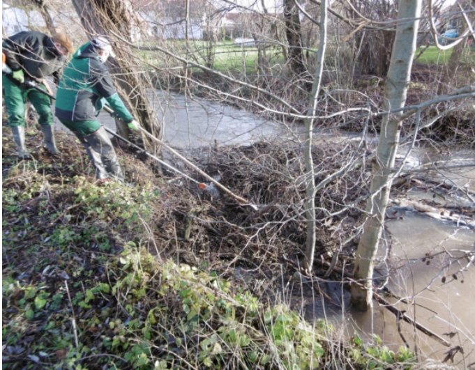
Abb. 24: Beseitigung von Treibgut, Totholz u. ä. (Foto: Leineverband)
