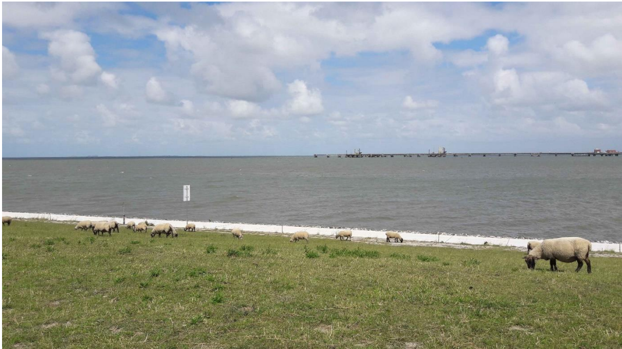
Abbildung 11.1-2: Jadebusen mit der Umschlaganlage Voslapper Groden (UVG) (F1)
