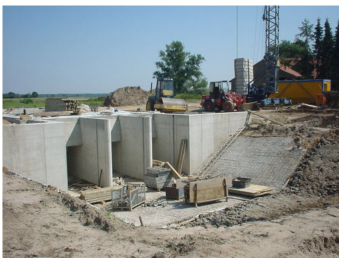
Abbildung 43: Baumaßnahme Schöpfwerk bei Frankenfeld
