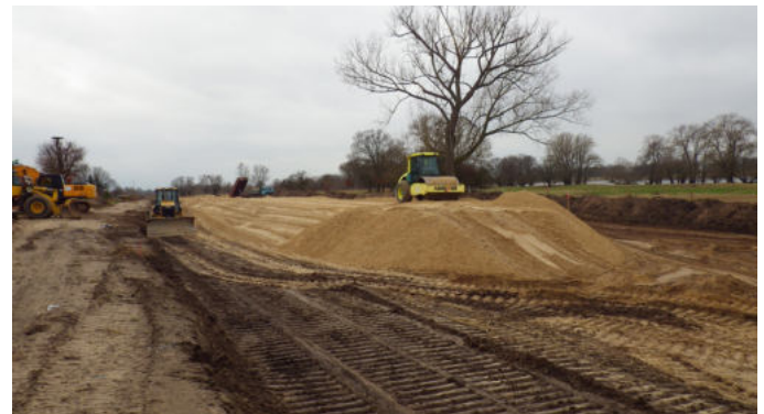
Abbildung 47: Deichbaumaßnahme bei Vietze – Neubau
