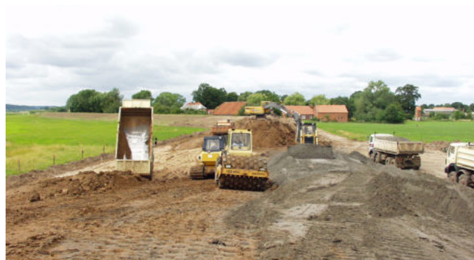
Abbildung 44: Deichverstärkung auf vorhandener Trasse bei Laake
