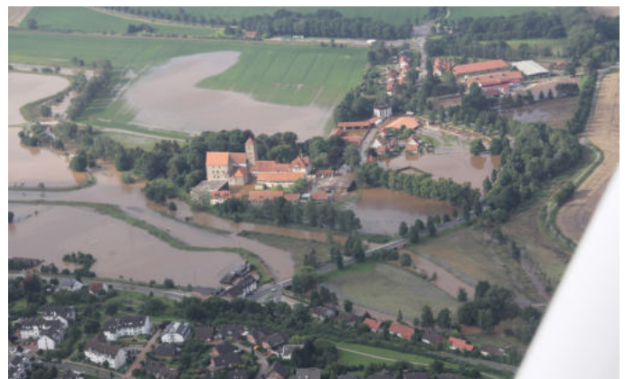
Abbildung 35: Hochwasser an der Innerste 2017, Itzum, Nds. Ministerium für Inneres und Sport, M. Voß
