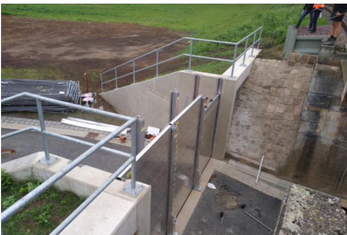
Abbildung 13: Deichscharte in der Deichlinie des Hochwasserschutzes Hoya
