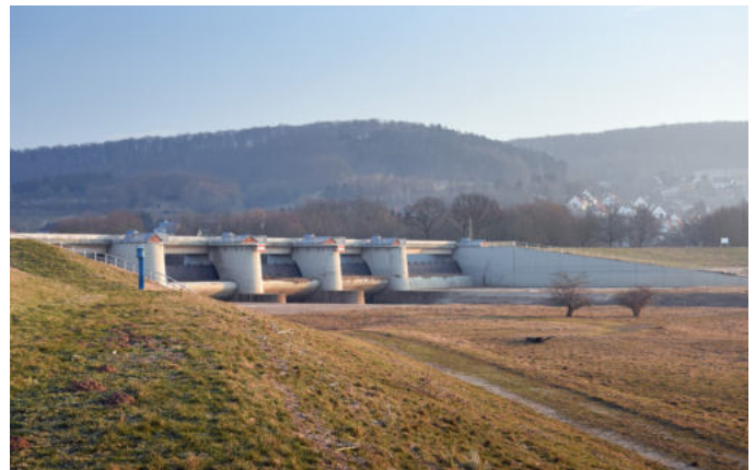
Abbildung 22: Hochwasserrückhaltebecken Salzderhelden, Abschlussbauwerk
