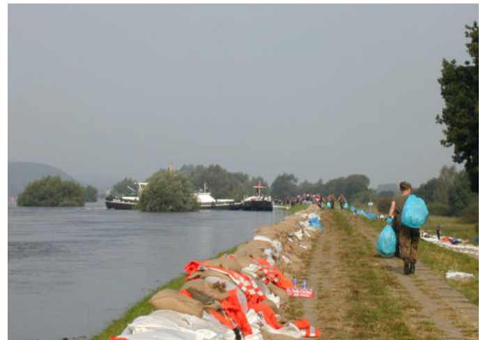
Abbildung 4: Deicherhöhung mit Sandsäcken
