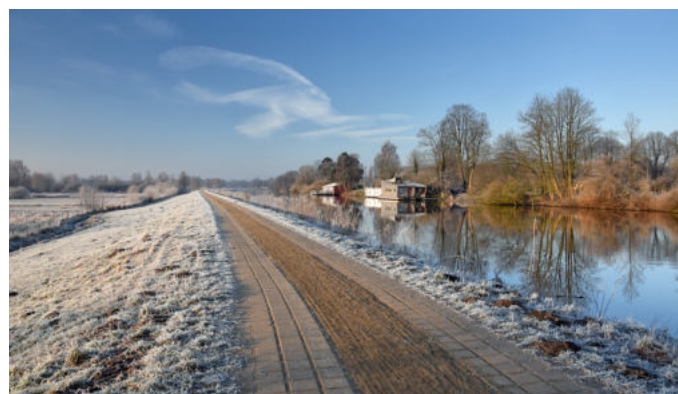
Abbildung 11: Dammstrecke mit Deichverteidigungsweg auf der Krone an der gehobenen Hunte in Oldenburg
