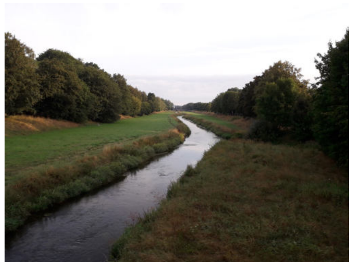
Abbildung 18: altes Hochwasserprofil (Doppeltrapezquerschnitt) der Leine, Göttingen
