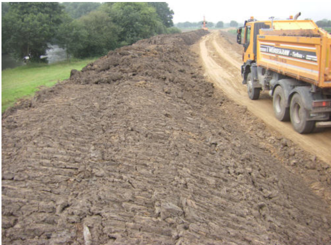
Abbildung 48: Deichbaumaßnahme in Meppen
