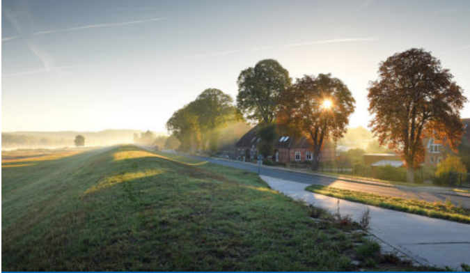
Abbildung 12: Deich an der Elbe bei Hittbergen mit Deichüberfahrt und Deichverteidigungsweg
