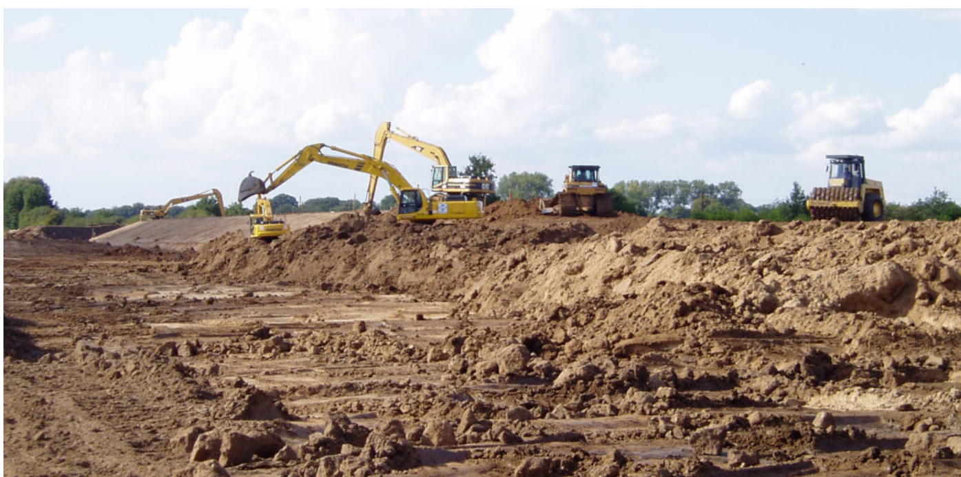
Abbildung 45: Baustelle Deichrückverlegung bei Rassau
