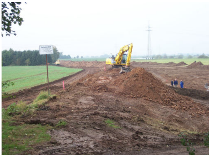
Abbildung 42: Deichbaumaßnahme bei Verden
