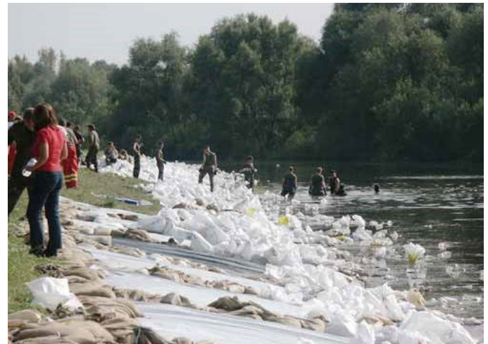
Abbildung 3: Deichsicherung mit Sandsäcken
