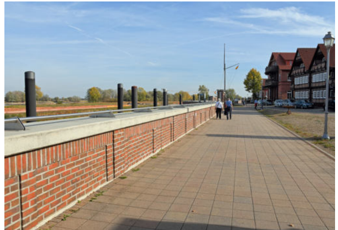
Abbildung 14: Hochwasserschutzwand in Hitzacker
