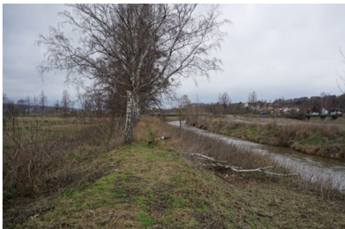
Abbildung 8: Deich (regional auch Damm bezeichnet) ohne gepflegte Grasnarbe und mit Bewuchs an der Innerste
