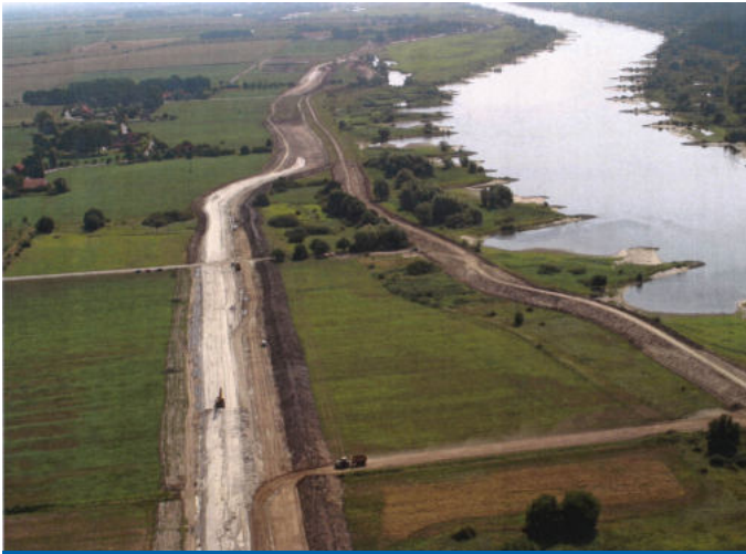
Abbildung 46: Baustelle Deichrückverlegung bei Rassau
