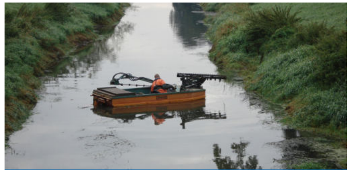
Abbildung 25: Unterhaltung (Unterwasser-Böschungskrautschnitt)
