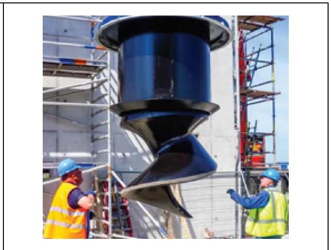
Abb. 11: Fischschonender Impeller einer Zentrifugalpumpe (Bosman Vision; aus SCHOLLEMA et al. 2018).
