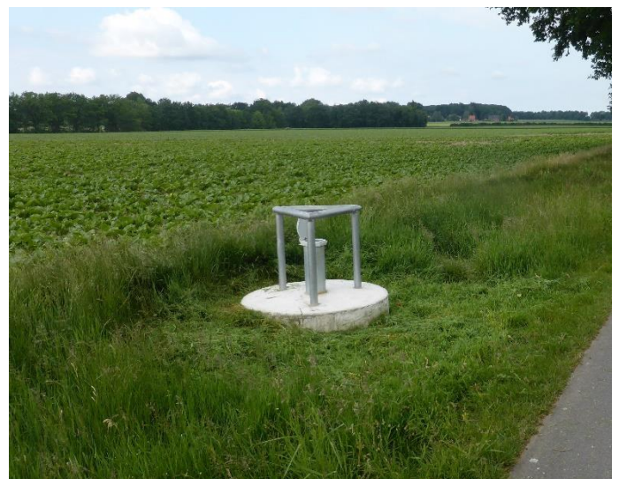
Bild 5: Grundwassermessstelle im Landkreis Uelzen
