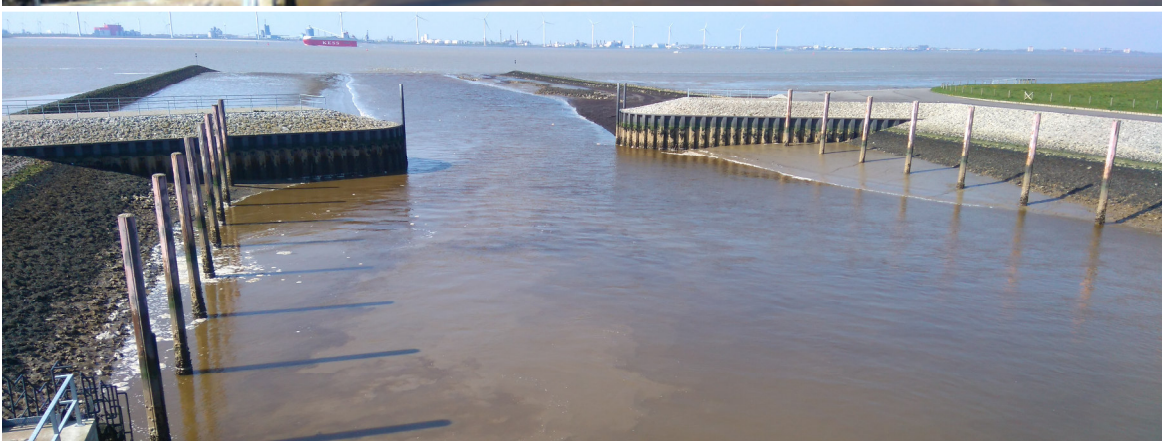
Abb. 11: Ausbreitung des Lockstroms („FD 1“; vgl. Abb. 10) zu Generierung des Brackwasserlebensraums zwischen den beiden Wassergleichständen im Ebb- und Flutstrom in der Außenmüde der Knock (Fotos: Finch).
