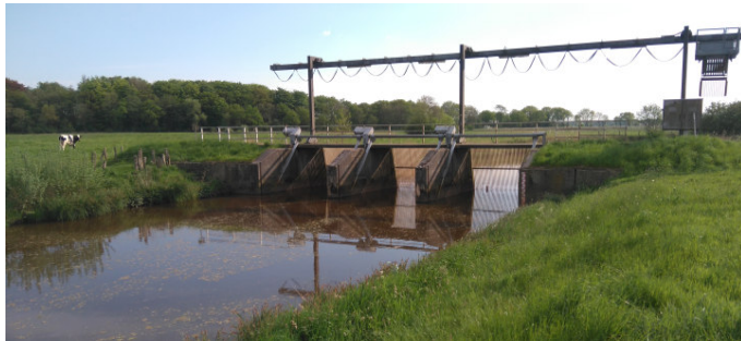
Die Stauanlage in Isums ist im Frühjahr und Herbst für Fische weitgehend durchgängig.
