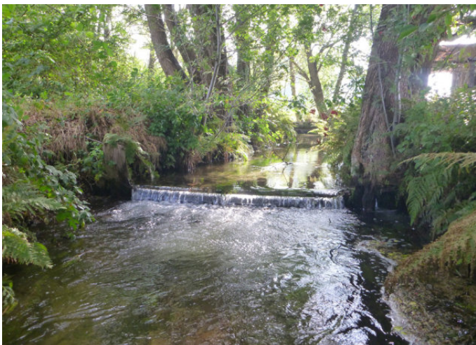
Abb. 6: Sohlabsturz, für kleine Fische unpassierbar (Foto: M. Hein)
