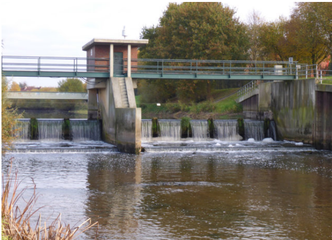
Abb. 5: Wehr an der Vechte (Foto: LAVES)
