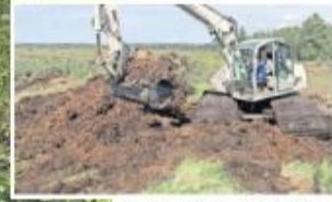
Bagger bei der Arbeit. Mit der großen Schaufel schichtet die Maschine den Torfboden zu einem Damm auf.
