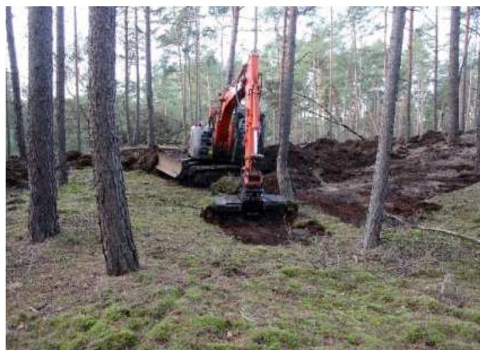
Abb. 21: Ein Bagger zieht die Moos- und Rohhumusaufgabe ab. (Foto: H.-J. Kelm, 16.12.2019)
