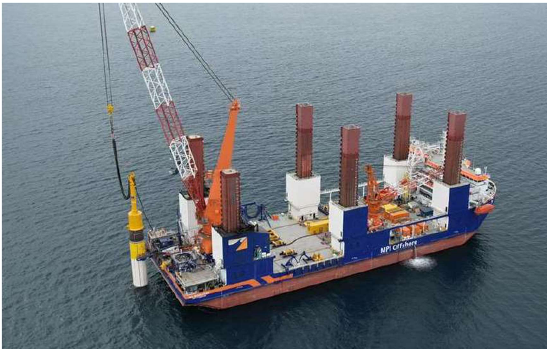
Abbildung 17: Positionierung der Monopiles vor dem Eintreiben
