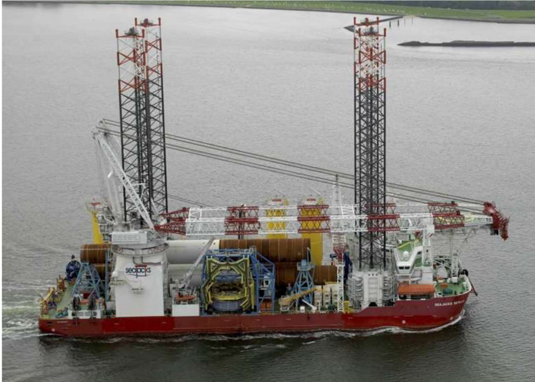
Abbildung 16: Installationsschiff zur Errichtung der Dalben (Beispiel)
