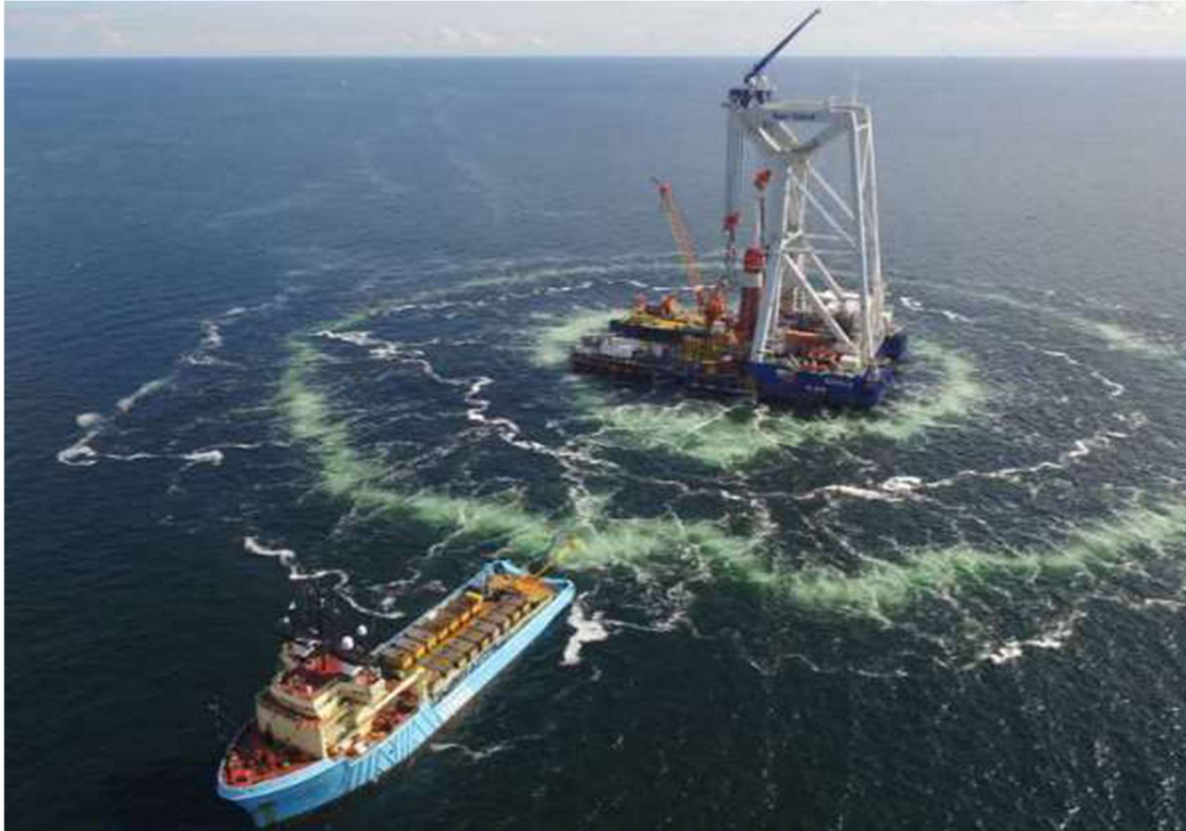
Abbildung 18: Doppelter Blasenvorhang im Einsatz
