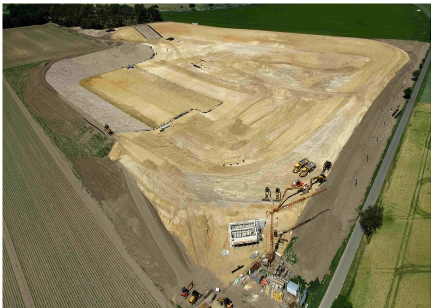
Abbildung 6: Wasserspeicher Borg in der Bauphase (Sommer 2014, Luftbild 13.06.2014, © Derek Belz)
