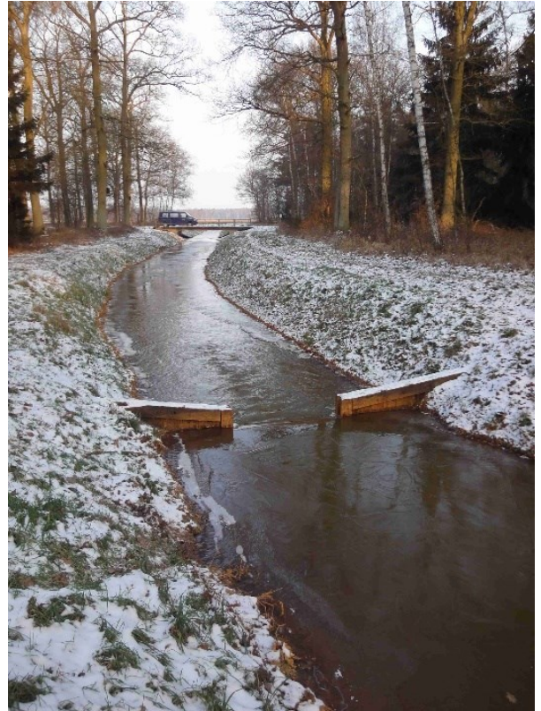
Abbildung 12: Stauanlage in der Lucie (Niedersachsen, Wendland)
