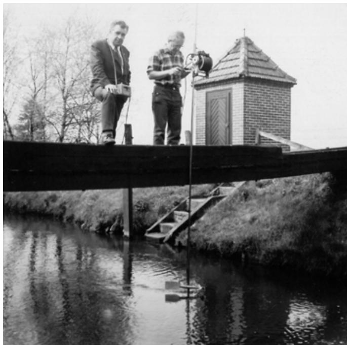
Abb 1: Abflussmessung (NLWKN)
