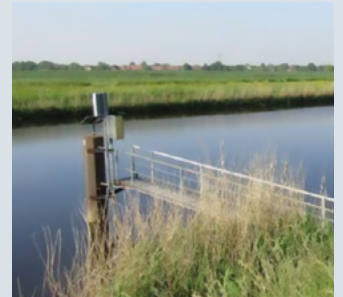
Pegel mit Ultraschall-Doppler-Anlage im Hadelner Kanal. Die Messsonde der Anlage ist unter Wasser montiert und nicht sichtbar.
