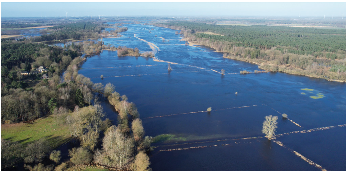
Großflächige Überschwemmung an der Wümme, Landkreis Rotenburg im Februar 2022.
