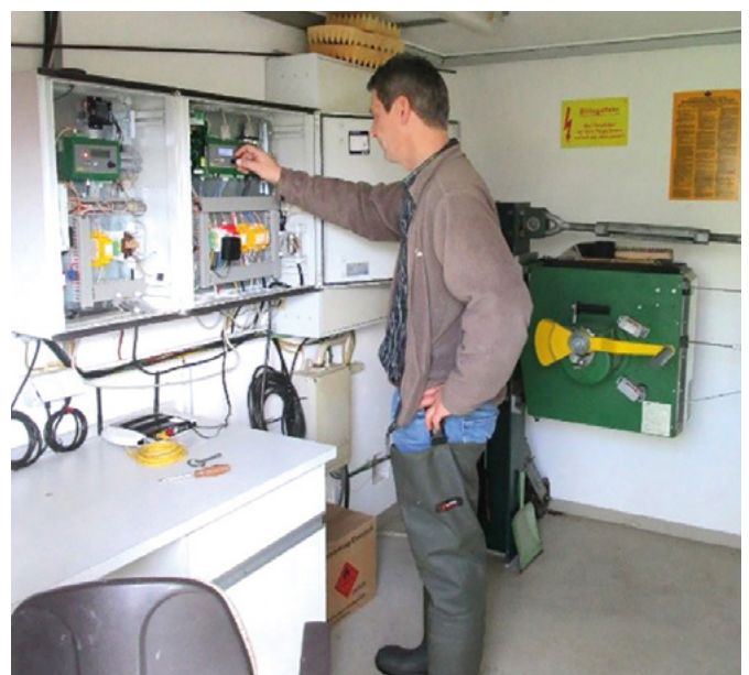
Die Messwerte der automatischen Datensammler werden regelmäßig mit den an der Pegelatte abgelesenen Werten verglichen.
