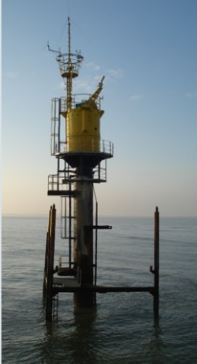
Messturm Ostfriesisches Wattenmeer, bestückt mit Wasserstands- und Windsensor, X-Band-Radar und Punktradar.
