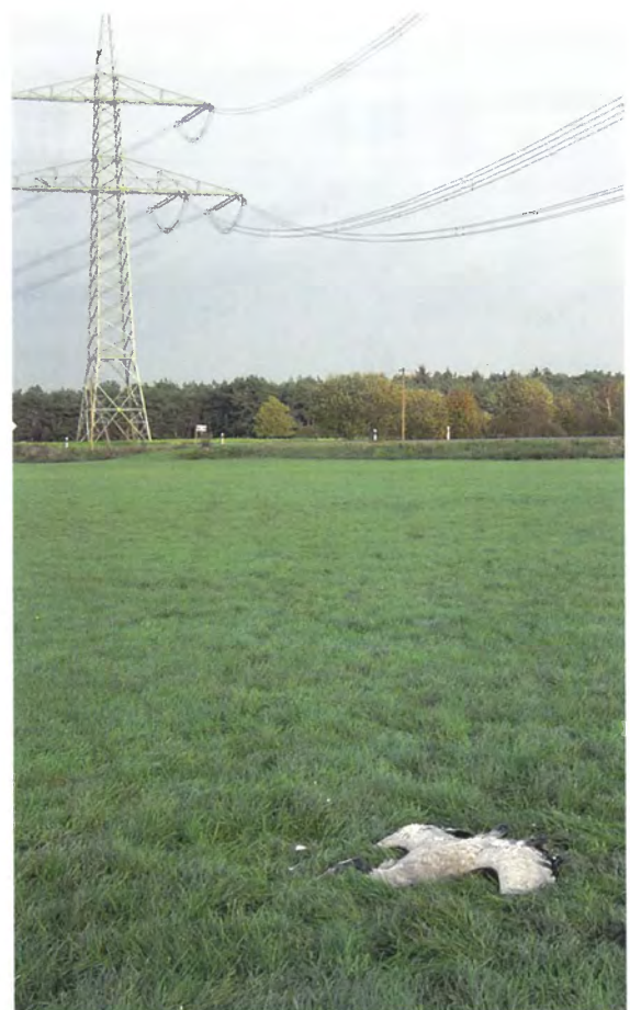
Abb. 37: Durch Leitungsanflug tödlich verunglückter Kranich, nördlich des Neustädter Moores, November 2006.
