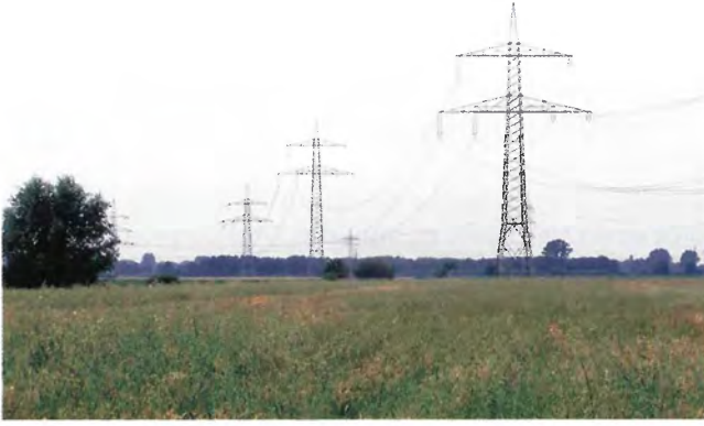
Abb. 3: Vorhandene 380-kV-Freileitung südlich des Rehdener Geestmoors. Foto: Frank Körner
