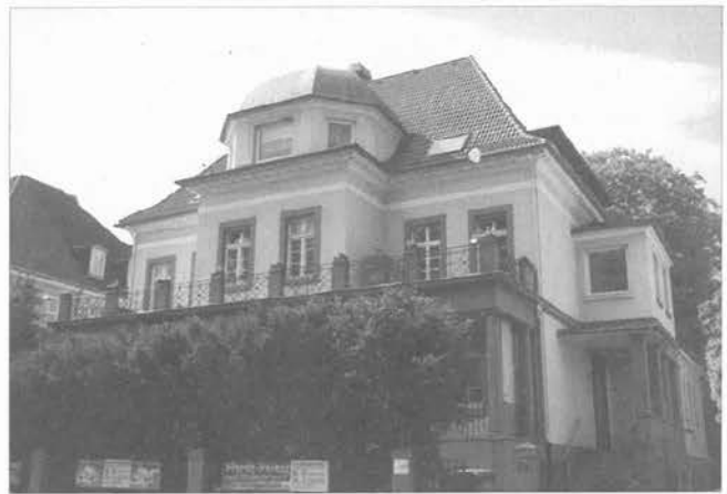
Abb. 33: Dienstgebäude Walderseestraße 21 in Hannover, 1955–1960. – Foto: H. Rettich 1997.
