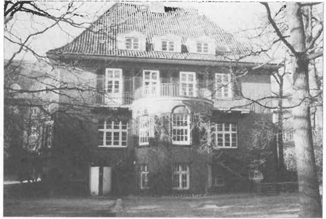
Abb. 37: Dienstgebäude Richard-Wagner-Str. 22 (1969–1984). Foto: H. Rettich 1997.
