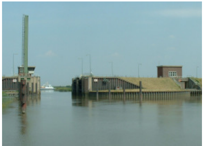
Abb. 5-3: Sperrwerk Wischhafen (Quelle: NLWKN)
