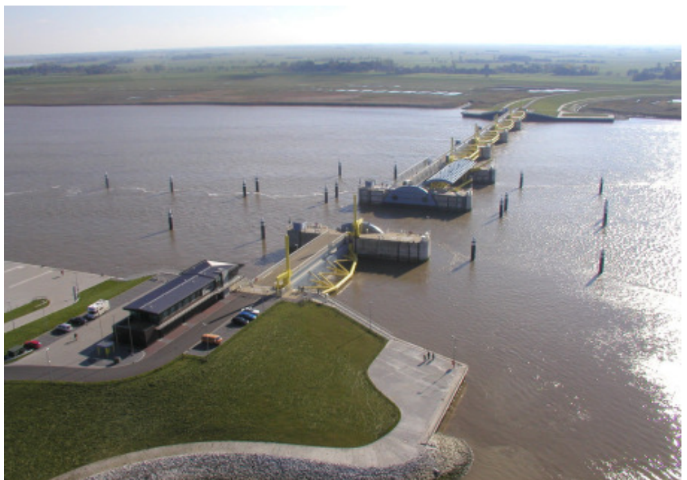
Abb. 3-1: Emssperwerk zwischen Gandersum und Nendorp im Landkreis Leer (Quelle: NLWKN)
