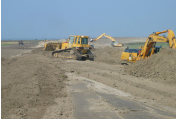
Abb. 5-2: Deichbaumaßnahme Rysum-Campen (Quelle: NLWKN)
