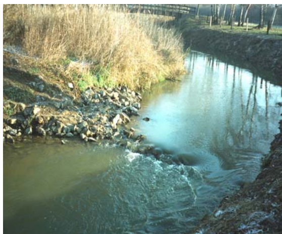
Strömungsenker in der Schunter bei Braunschweig-Querum
