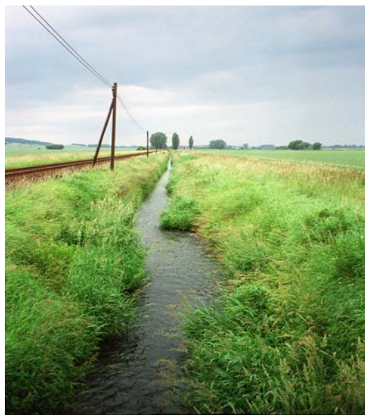
Altenau bei Weferlingen, die Uferabbrüche wurden inzwischen beseitigt.
