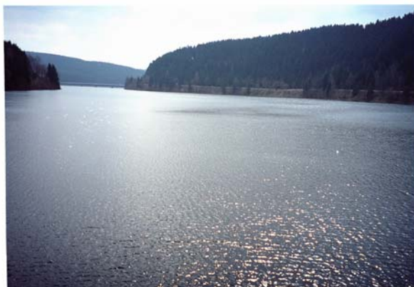
Blick auf die Okertalsperre in Richtung Altenau
