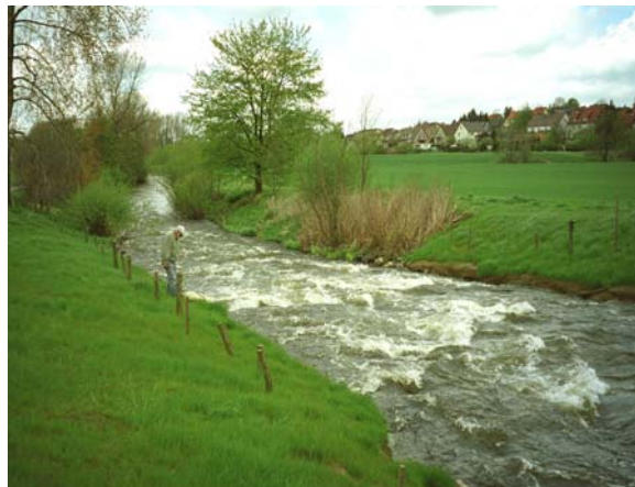
Die neue Sohlgleite bei Börßum
