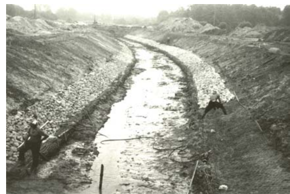
Ausbau der Schunter, als Uferbefestigung werden Wasserbausteine und Faschinen eingebaut.
