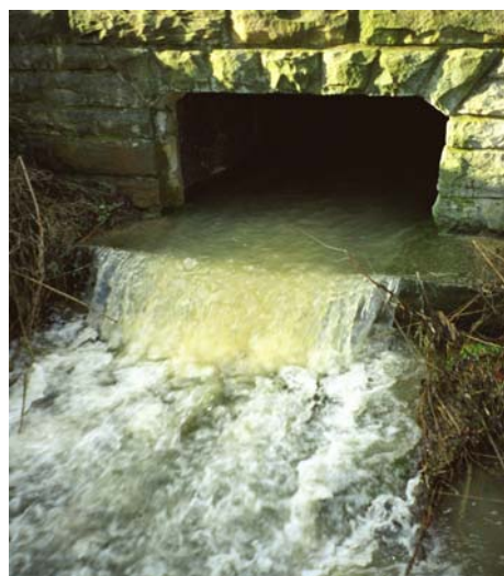
Sohlabsturz im Schambach
