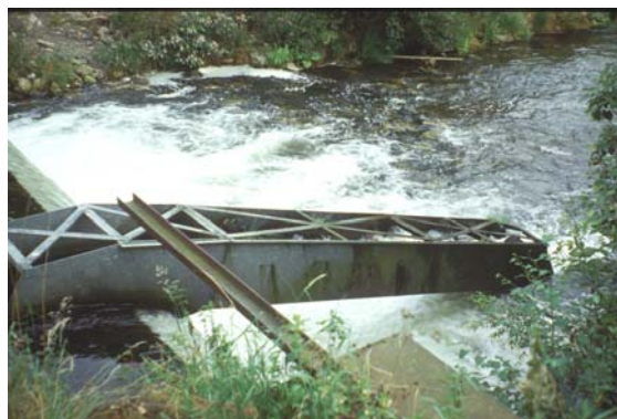
Fischeaufstieg an einem Sohlabbsturz in der Oker bei Vienenburg
