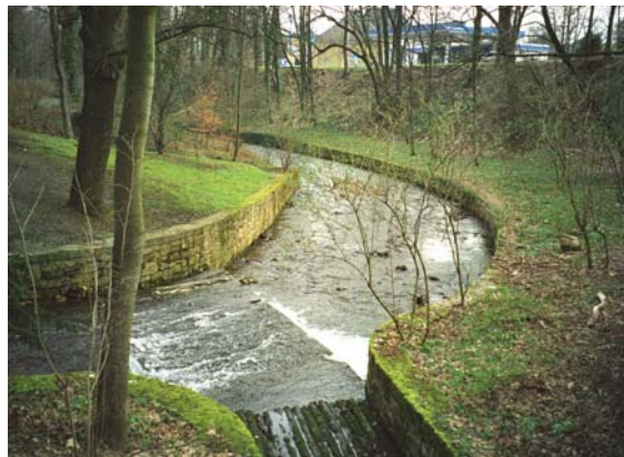
Abzucht am „Wasserloch“ in Goslar
