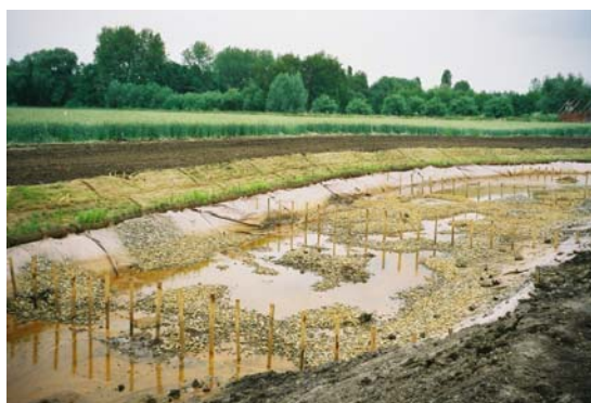
Neues Bett der Schunter bei Braunschweig-Bienrode während des Ausbaus.
