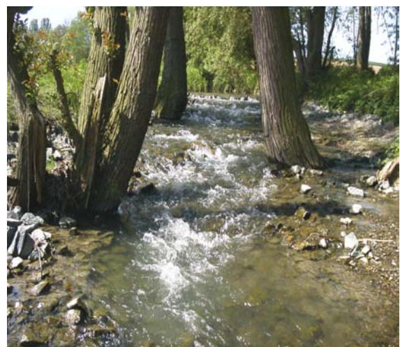
Neue Sohlgleite westlich der Oberen Schierksmühle (Foto. U. Luckau)
