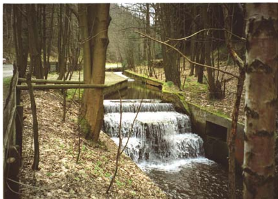
Sohlabsturz in der Abzucht oberhalb Herzberger Teich
