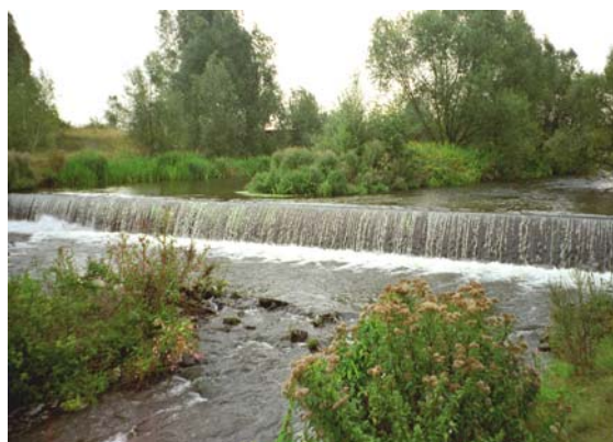
Sohlabbsturz an der schwarzen Brücke
