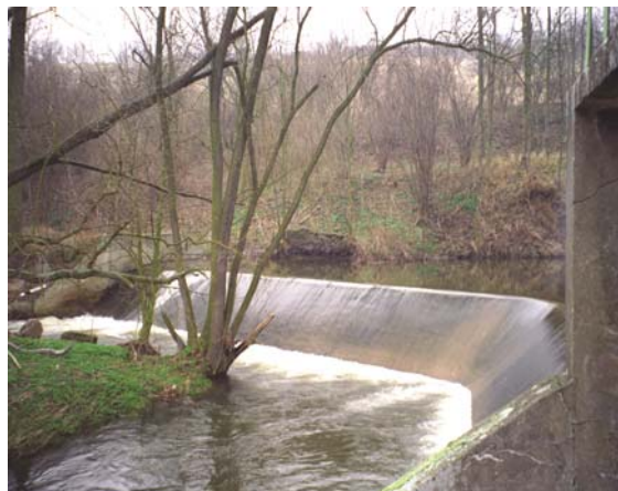
Abschlagbauwerk in der Ilse südlich von Hornburg
