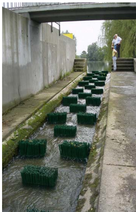
Der Fisch-Kanu-Pass am Wehr in Rünigen wird geflutet. (Foto P. Siering)
