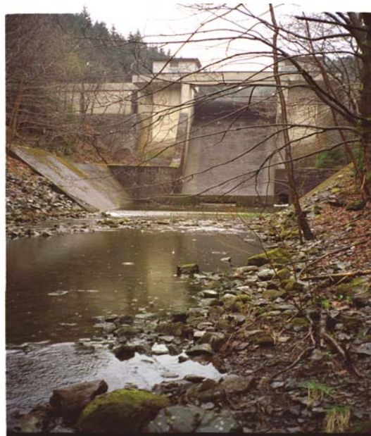
Oker unterhalb Ausgleichsbecken, aus dem nur sehr wenig Wasser abgelassen wird. Das meiste Wasser wird einem Kraftwerk zugeleitet.
