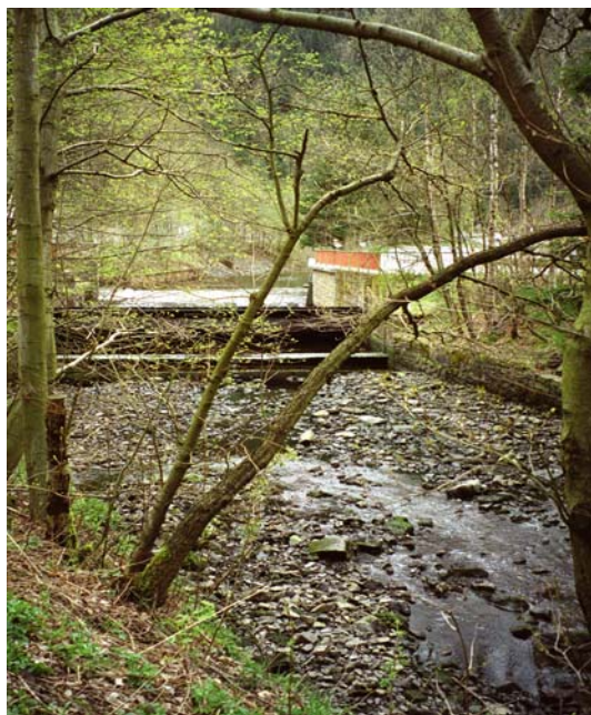
Oker unterhalb Kraftwerk Romkerhalle, während der Ableitung in den Oker-Grane-Stollen
