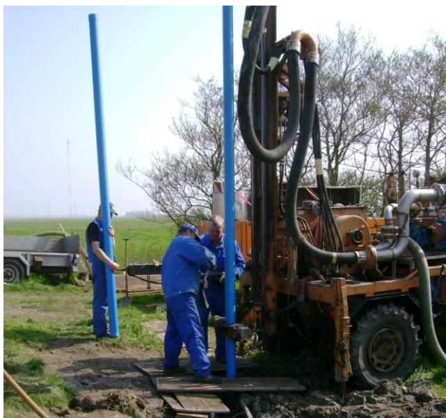
Abbildung 7: Neubau einer Grundwassermessstelle
