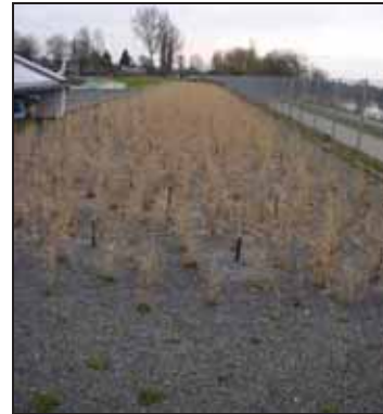
Bodenfilter Halenreihe Hamburg (links) und Stadionbad Bremen (rechts) [Bildquelle: s.o.]
