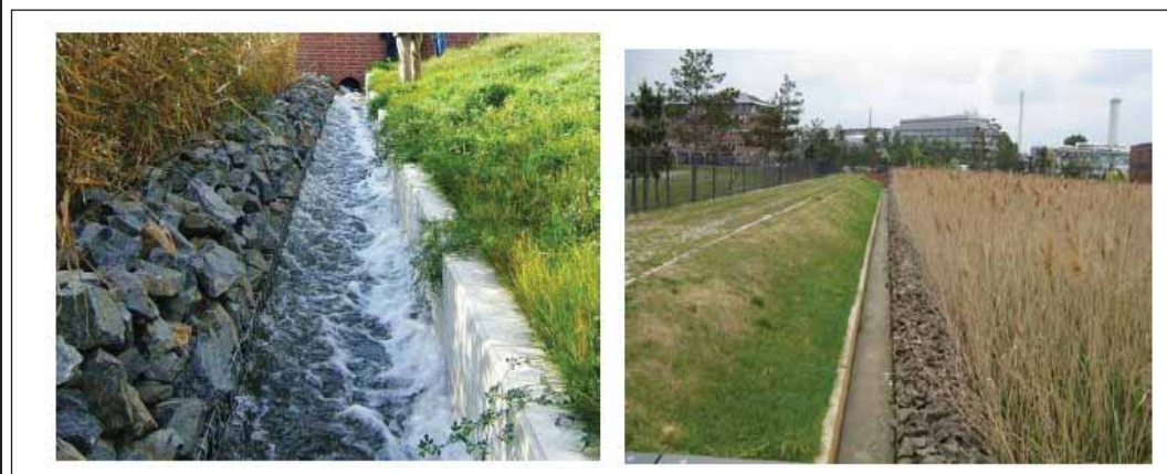
Verteilergerinne des Bodenfilters Adlershof und nach 4 Jahren Betrieb [Bildquelle: Fuchs et al., 2008]
