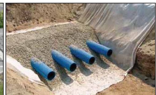
Rohr-Rigolenversickerung [Bildquelle: BSU, 2006]
