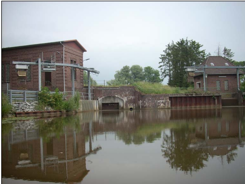
Foto 3: Schöpfwerk am Basbecker Schleusenfleth.
