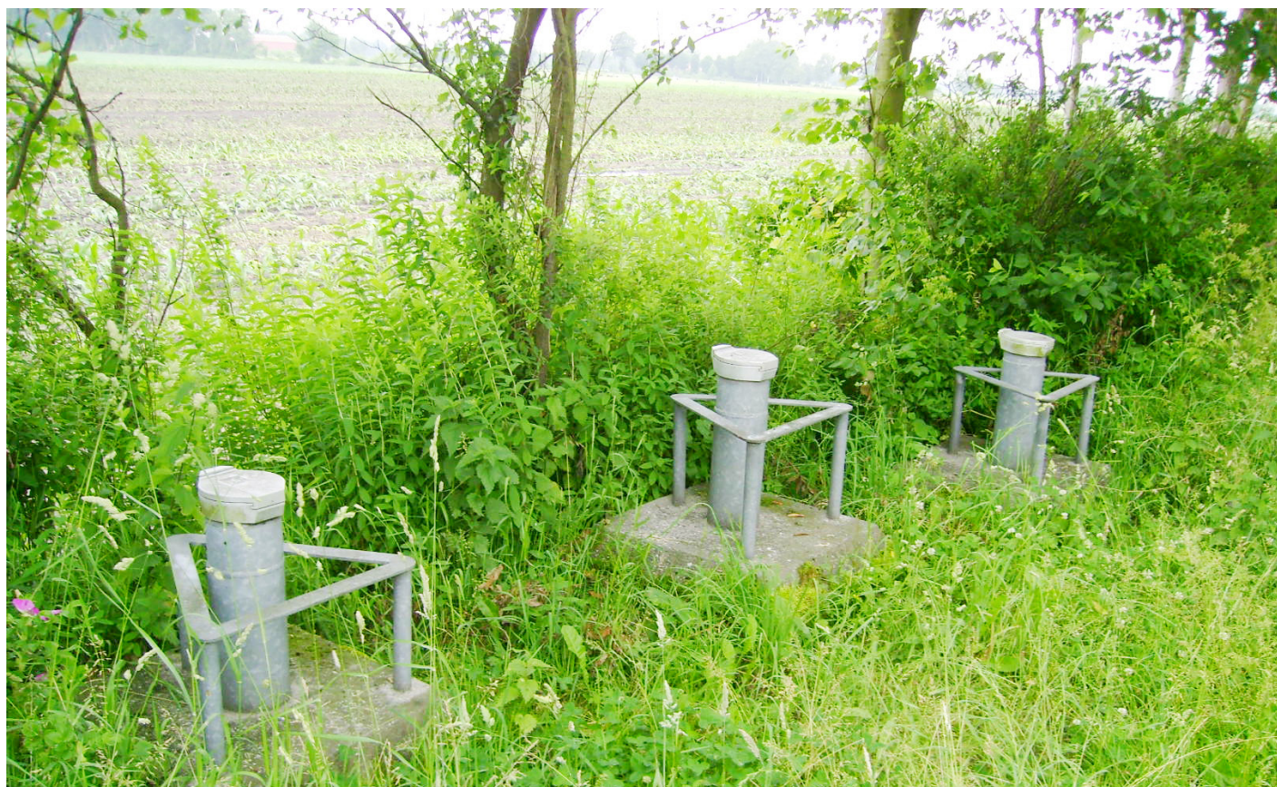
Grundwasser-Messstellengruppe Ardorf (Ausbau in drei Grundwasserleitern)
